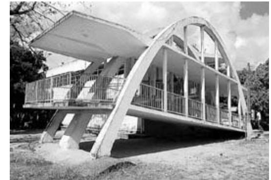
3.55. Escola Alberto Torres. Detalle de la rampa.
