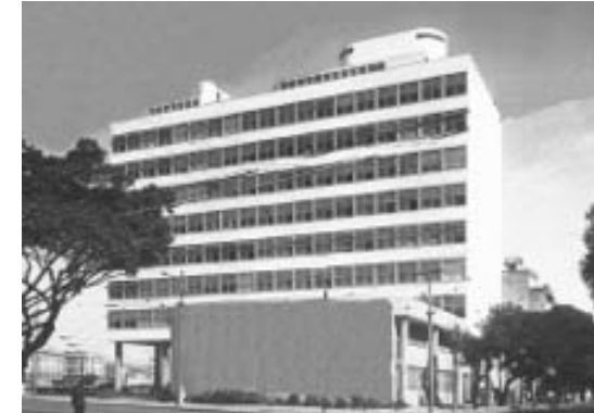
3.6. Edificio de la Secretaria de Fomentos de Estado de Pernambuco.
