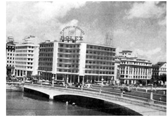
2.6. Puente de acceso a la avenida Guararapes en el barrio de Santo Antônio.
