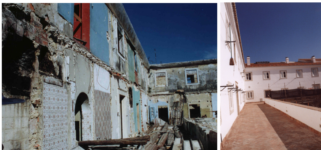
Fig. 86 y 87. Corredor superior del claustro. Durante las demoliciones y su estado actual.
