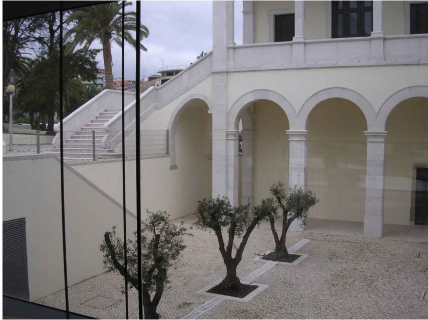
Fig 97. Patio lateral. Estado actual. Para recuperar el patio lateral fue necesario excavar una profundidad equivalente a la altura de los pilares, lo que significó un desnivel respecto a la calle que sirvió para crear el volumen de entrada, bastante abierto y con rampas.
