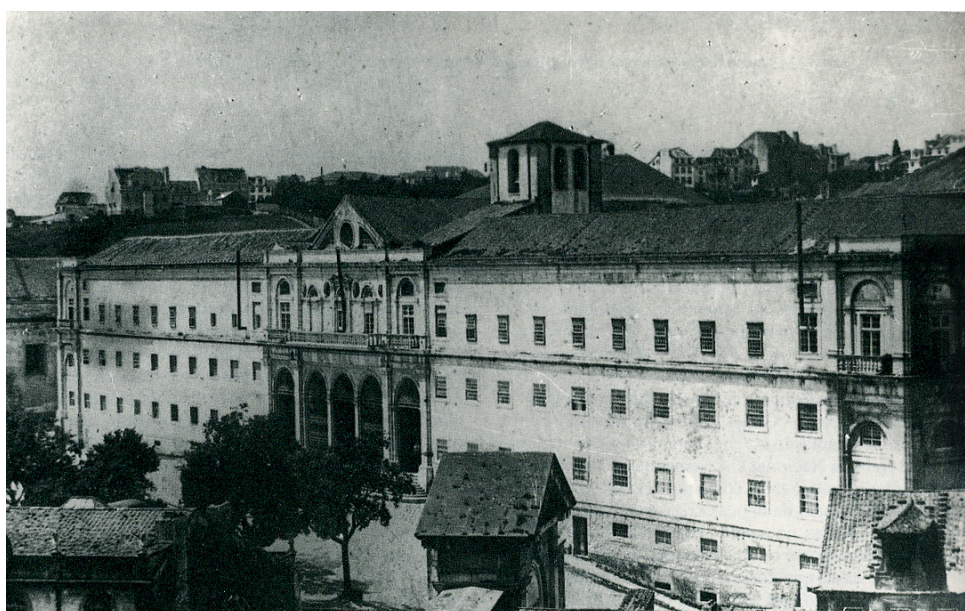
Fig. 65. Vista de la fachada principal antigua del Convento de São Bento.
