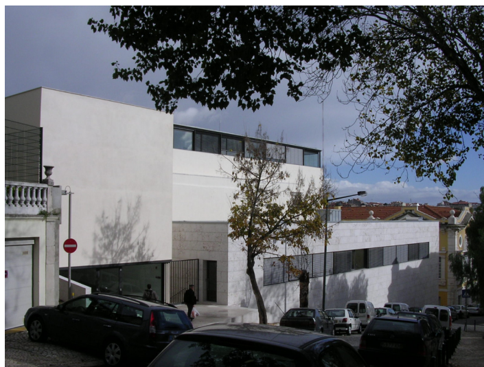
Fig. 94. Cuerpo en entrada por la Rua do Quelhas , después de la intervención. El nuevo edificio que envuelve lo que resta de convento, tiene un lenguaje contemporáneo y uniforme, y desde la entrada permite ver una parte del antiguo convento.
