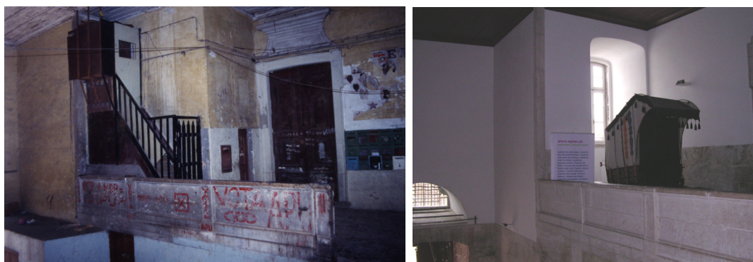
Fig. 79 y 80. Entrada a la antigua capilla, antes de la intervención y actualmente.
