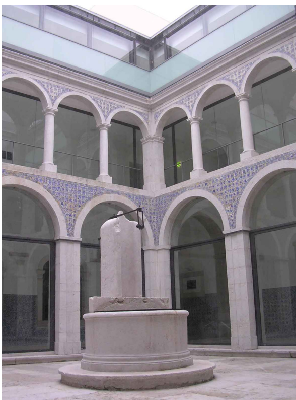
Fig. 98. Claustro. Estado actual. La recuperación de los arcos del patio implicó remover la carpintería de aluminio que existía. La decisión de cerrar los arcos con grandes paneles transparentes en marcos de hierro, no fue la más fácil, mas fue solicitada por los dueños de la obra. Para el arquitecto, no debería romperse la continuidad espacial del claustro.
