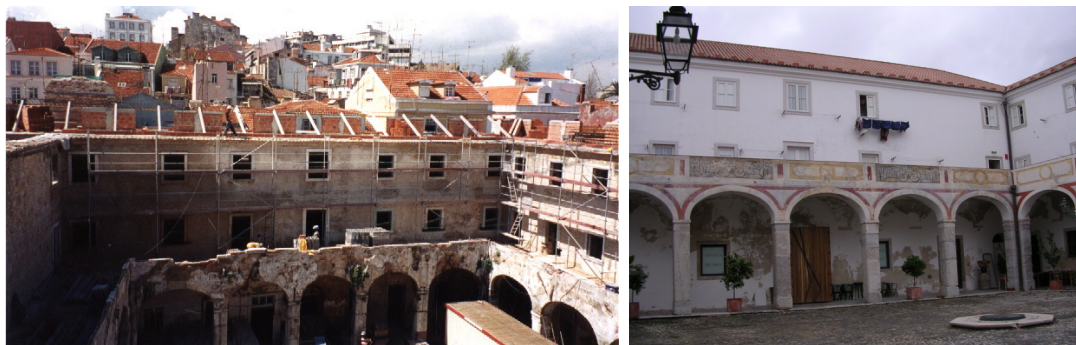
Fig. 84 y 85. Imágenes del claustro durante las obras y su estado actual.
