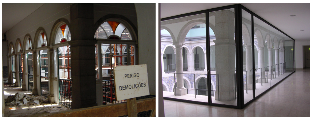
Fig. 95 y 96. Vista del claustro desde la arquería superior. En la foto de obra, podemos ver los vanos de los arcos cerrados por marcos de aluminio, mientras que en la foto actual vemos los arcos limpios con una estructura de hierro y vidrio que crea la idea de un corredor interior y otro exterior, al mismo tiempo que protege del viento y de la lluvia. La transparencia del vidrio (desde el interior) permite una visión continua del espacio del patio, mas parecido a como debió ser originalmente.
