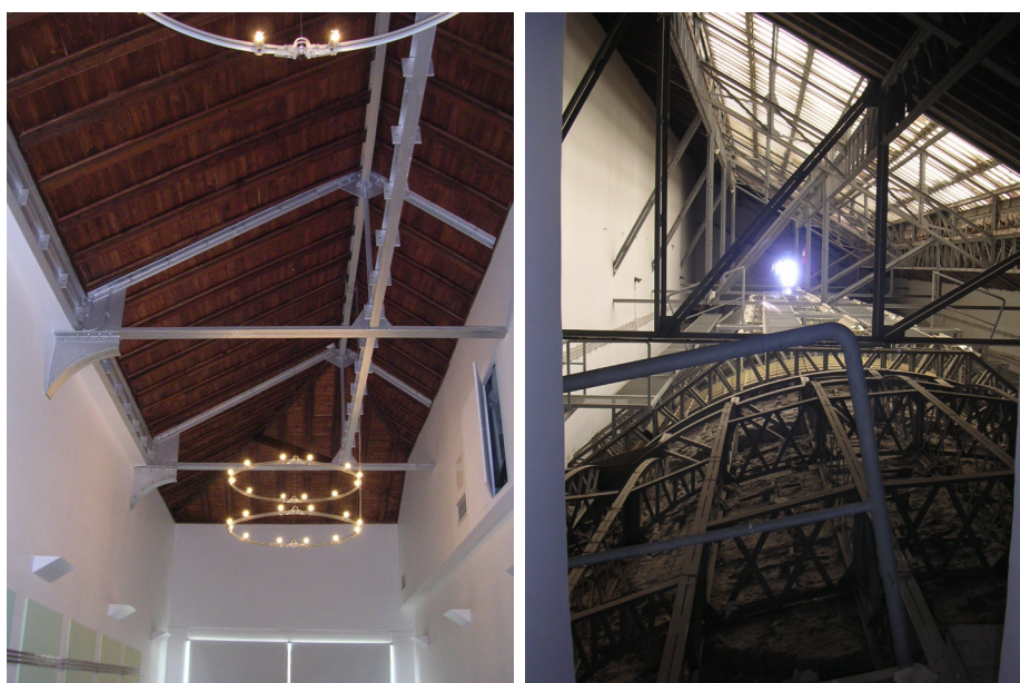
Fig. 75, 76. Sala recuperada del último piso, que comparte el mismo tipo de estructura que la soportas las bóvedas inferiores.
