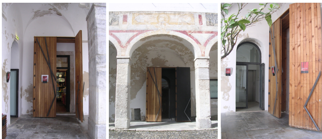
Fig. 90, 91 y 92. Museo de la Marioneta. Entrada/Salida del museo hacia el patio central, las puertas fueron protegidas por unas cajas de madera y hierro de lenguaje contemporáneo siguiendo el estilo de las "cajas" interiores creadas para la exposición.
