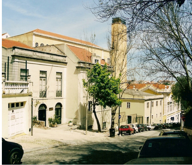
Fig. 93. Cuerpo en entrada por la Rua do Quelhas , antes de la intervención. Podemos observar que lo que existía era un conjunto dispar de construcciones y agregados inconexos que en nada recordaban el antiguo convento.
