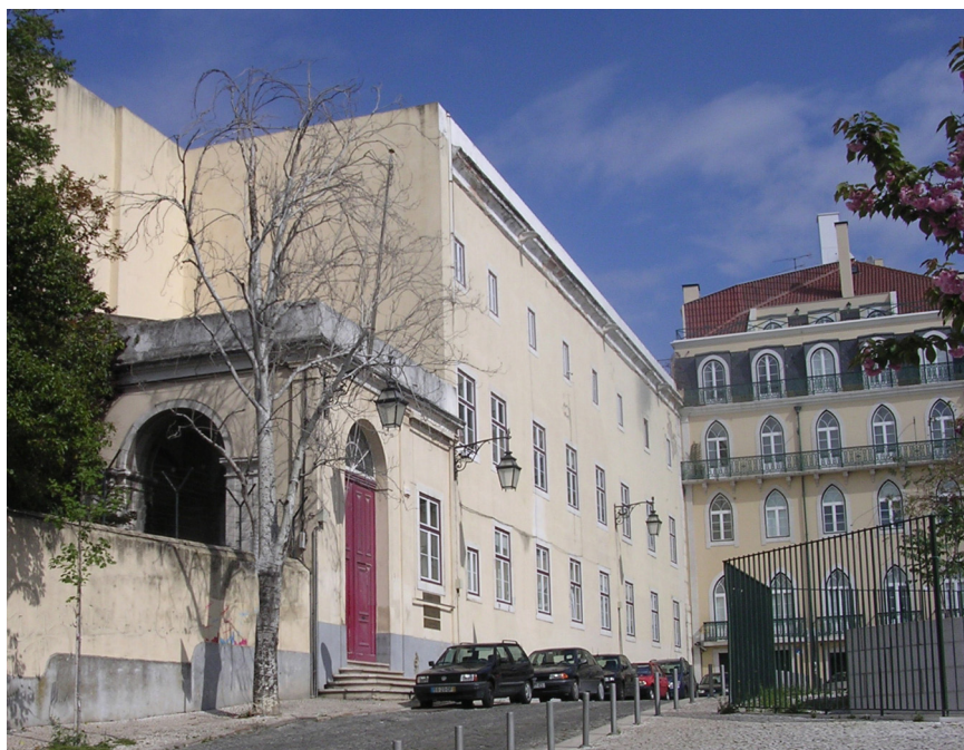
Fig. 54. Entrada principal de la Escuela de Bellas Artes. Esta fachada es el resultado de la demolición de la Iglesia, que se encontraba adosada a esta pared, para dar iluminación natural a la Sala de lectura de la Biblioteca.
