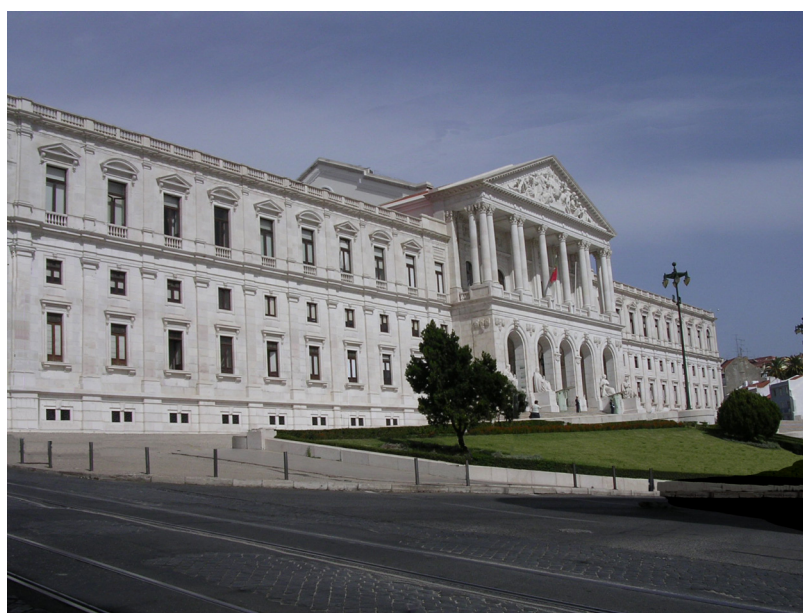
Fig. 66. Vista de la fachada principal del Parlamento. Aspecto que ganó a partir de la remodelación de Miguel Ventura Terra, a raíz de un incendio de 1895.
