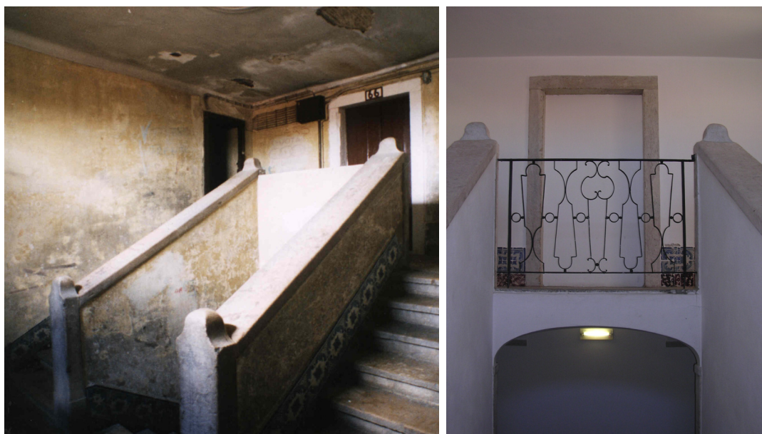
Fig. 88 y 89. Escalera interior. El forjado de hierro estuvo cubierto por cemento.
