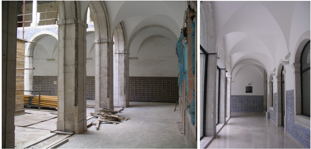
Fig 103 y 104. Corredor del claustro durante las obras y estado actual.
