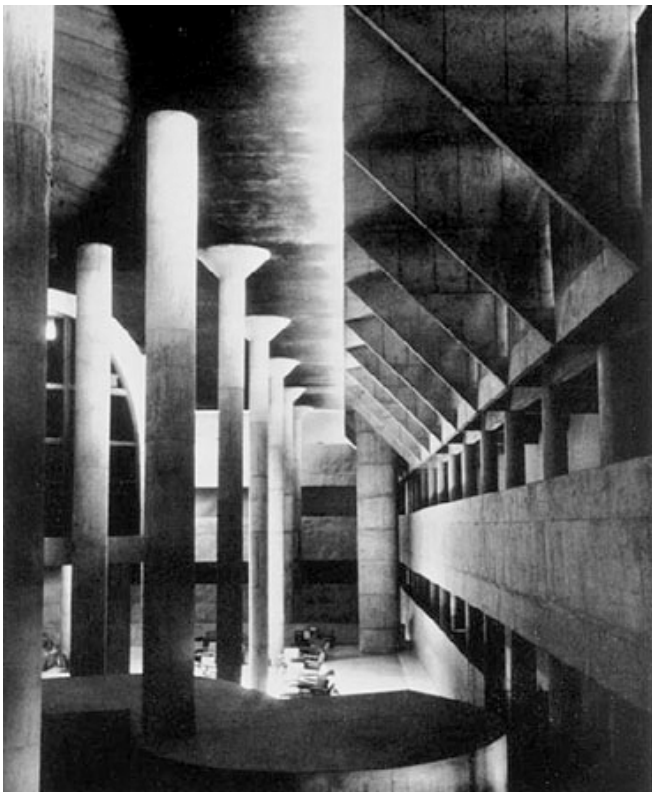
La sala en penumbra del palacio de la Asamblea. Arriba, luna artificial (FLC L3.10.155) Abajo, sobre el eje de la imagen, «un intervalle de quelques centimètres» separa la cubierta de la canal apoyada sobre ménsulas. Al fondo uno de los bajantes.
