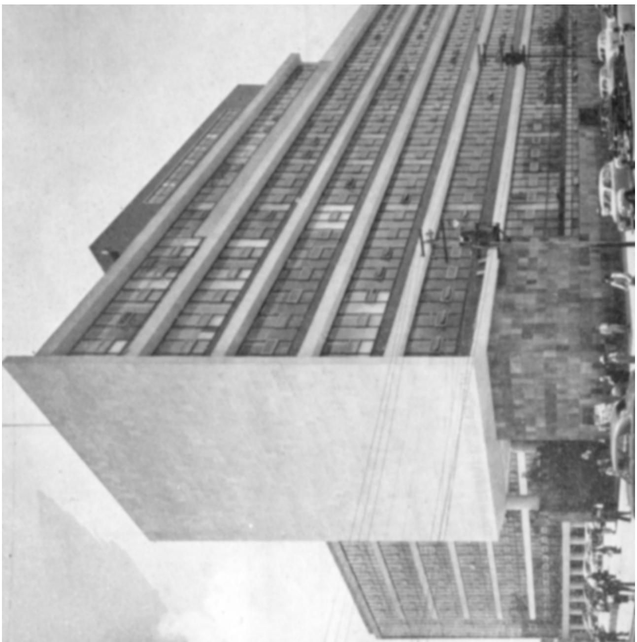
376 Ídem. La planta baja retrasa el cerramiento despegando al edificio del suelo. Las plantas superiores en el sentido largo se abren de suelo a techo. Los muros ciegos cobeceros rebosan el alineamiento de la fachada enfatizando su papel de cierre del edificio.
