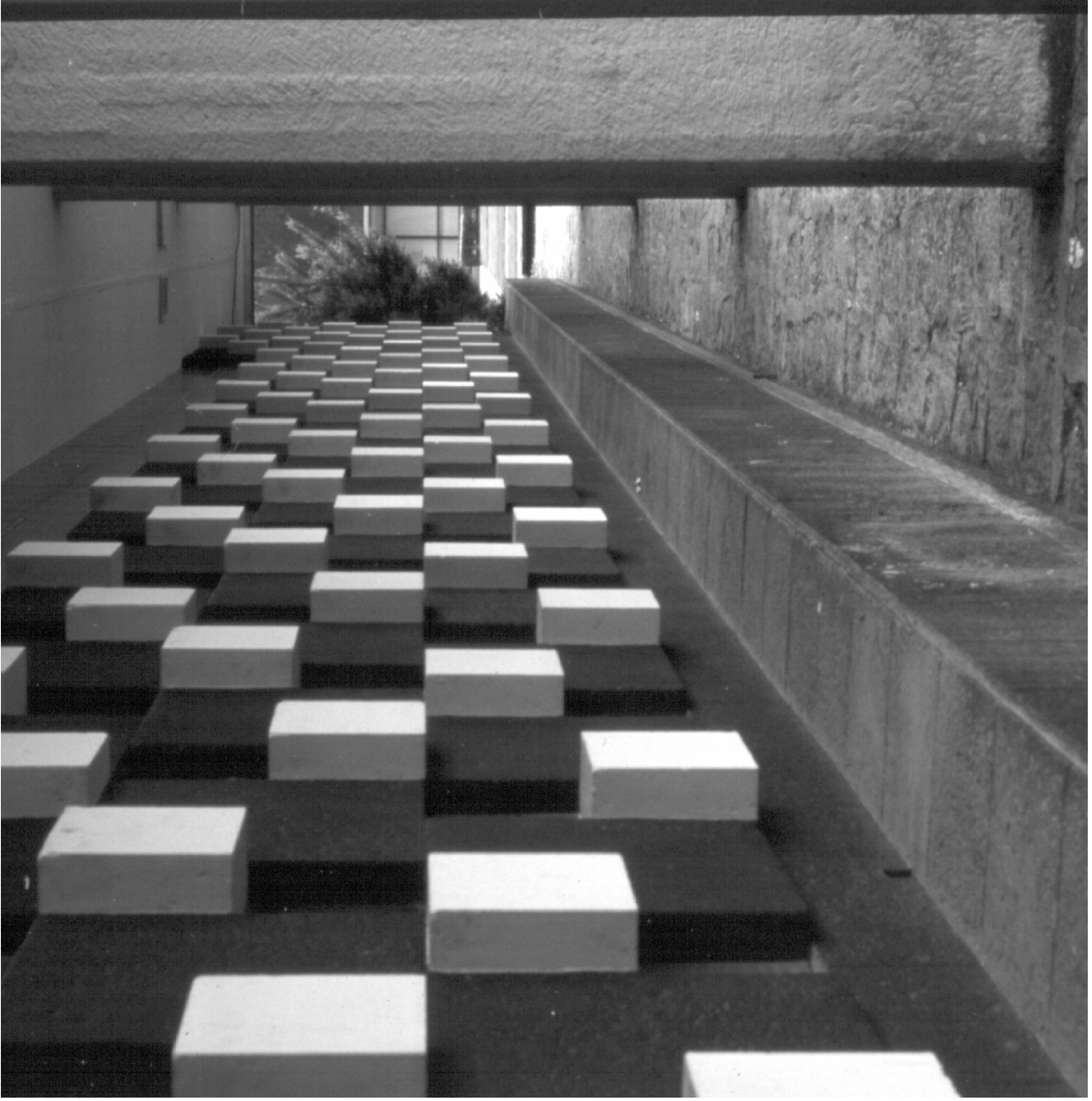
260 Ídem. Uso moderno de los materiales, en este caso del hormigón para dar acabado al muro en la planta baja. Se observa un juego de pequeños prismas que dan textura al basamento.
