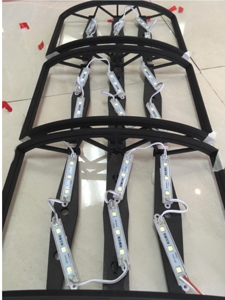
Figura 96: Instalación de soportes de cuadros, maderas y luces LED. Imagen hecha por el autor.
