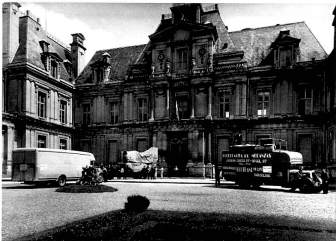
Fig. 46 Arribada de les obres de l'exposició d'Art Català a Maisons-Laffitte , París, juny de 1937. ANC
