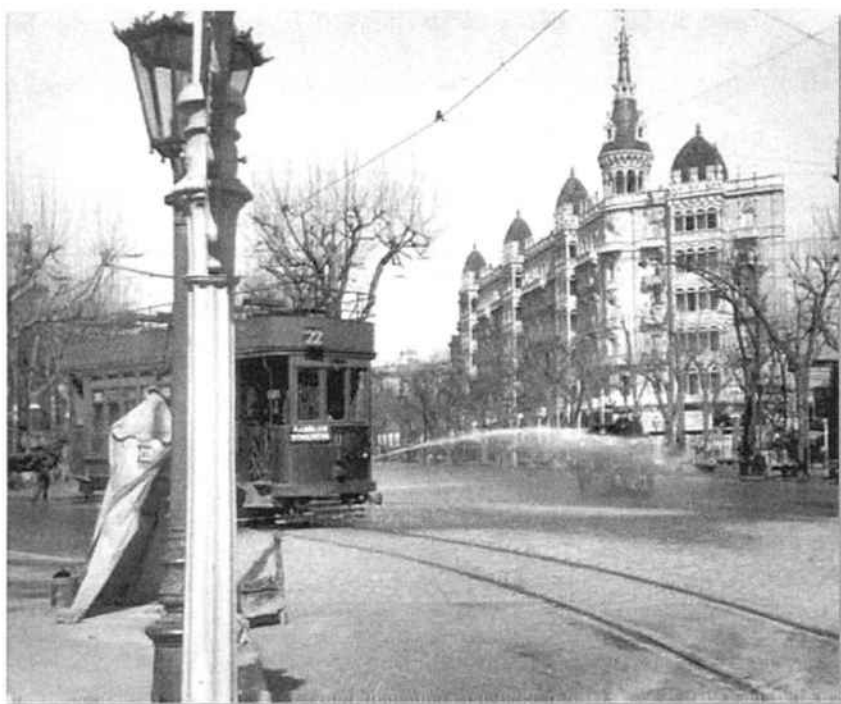
Fig. 148a Edifici « Cases Rocamora », 1914 – 1917-20. Passeig de Gràcia, n° 6, 8-10 i n° 12 – 14 amb carrer Casp n° 1 de Barcelona
