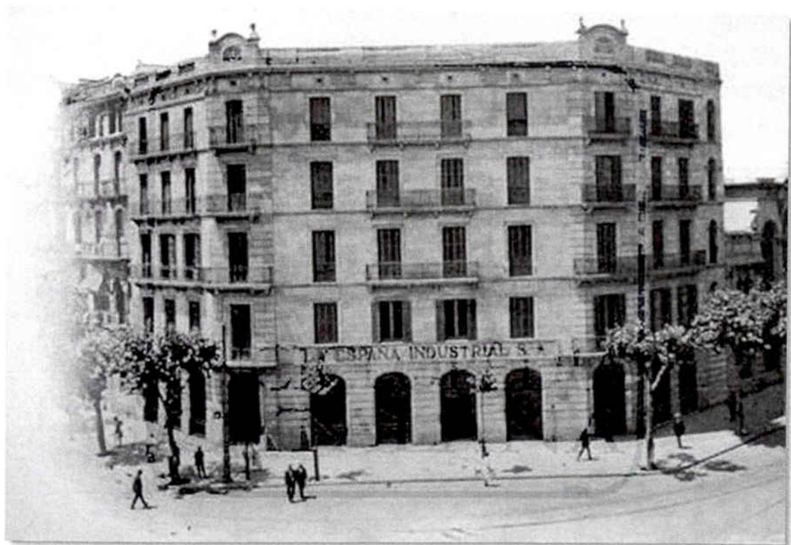
Fig. 253 Oficines de La España Industrial a la Plaça Urquinaona de Barcelona, primera meitat del segle XX. Fototeca de Catalunya
