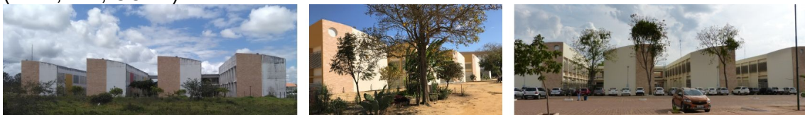
Figura 157: Fachadas con revestimiento cerámico en los tres pabellones de aulas (MAR; ALT; CONT)
