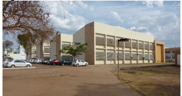
Figura 235: Fachada lateral derecha
