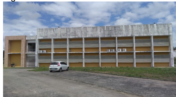
Figura 201: Fachada lateral derecha
