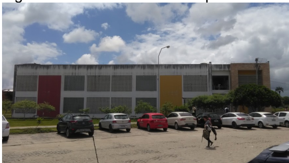
Figura 200: Fachada lateral izquierda
