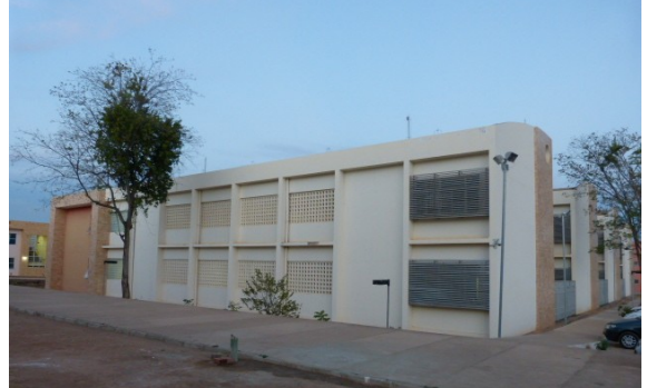
Figura 233: Fachada lateral izquierda
