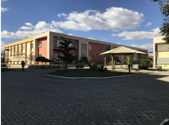
Figura 214: Vista general de la edificación
