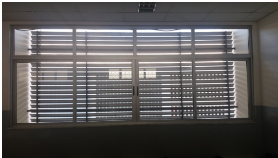
Figura 206: Aula A101: ventana y lamas exteriores
