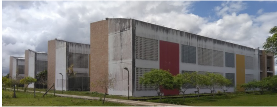
Figura 202: Fachadas lateral izquierda y del fondo
