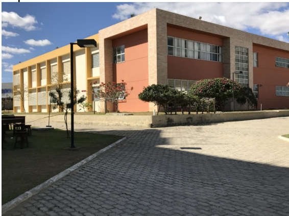
Figura 218: Fachadas principal y lateral izquierda
