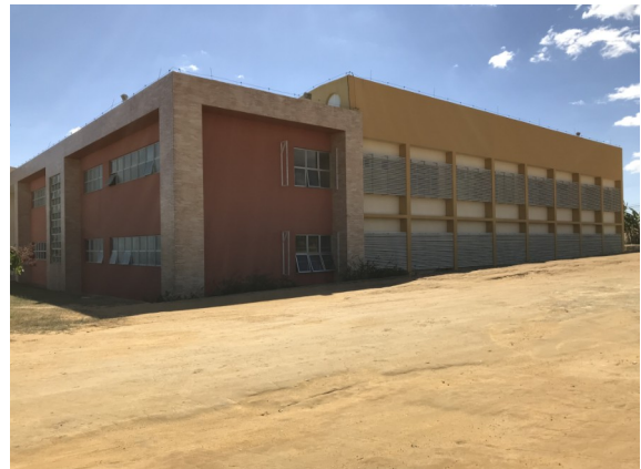
Figura 219: Fachadas principal y lateral derecha
