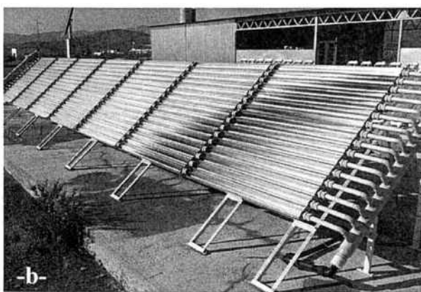
Figura 1.29. (a) Reflexión sobre un reactor CPC, toda la luz solar que llega a la apertura del colector será reflejada alrededor del reactor si el ángulo de incidencia es menor que el ángulo de aceptación del CPC. (b) ejemplo de instalación CPC.
