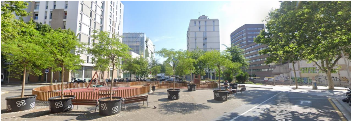
Imagen 32. Evolución urbana de la intersección de Sancho de Ávila con Ciutat de Granada. De arriba a abajo, abril 2016 (situación previa a la Superilla), abril 2017 (urbanización provisional de la Superilla entre septiembre de 2016 y octubre de 2017) y julio 2019 (urbanización definitiva de la Superilla, noviembre de 2017 a actualidad). Fuente: Google Street View.
