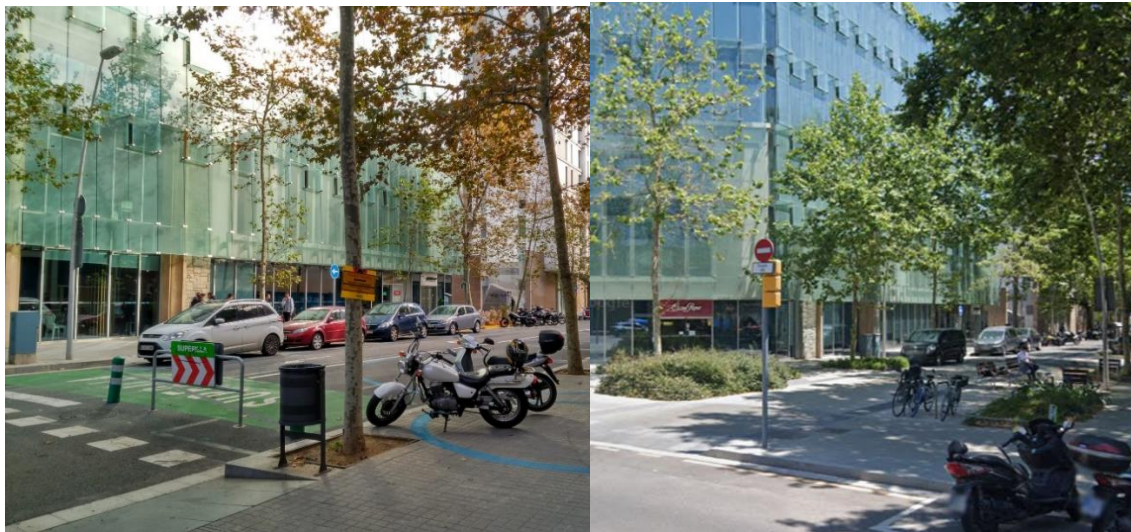
Imagen 21. Detalle del acceso a la Superilla de calle Ciutat de Granada con Tànger. A la izquierda durante los primeros meses de la implementación de la Superilla en noviembre de 2016. Fotografía propia. A la derecha urbanización definitiva del acceso con un tramo de plataforma única elevada e instalación de parterres y árboles en suelo. Fotografía de 2021. Fuente: Google Maps.
