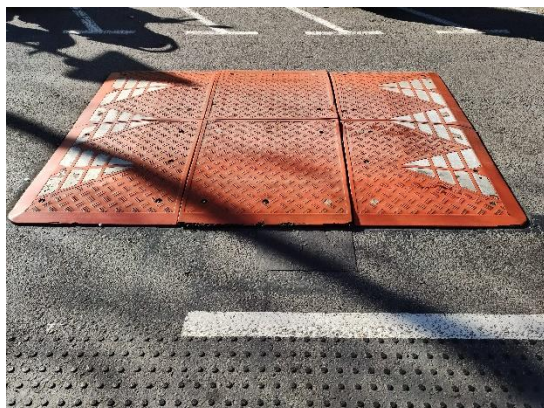
Sistema reductor de la velocidad ubicado en Roc Boronat.
