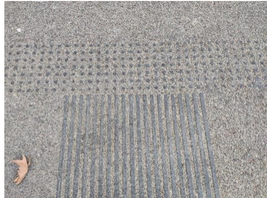
Detalle de las bandas podotáctiles de un paso de cebra.
