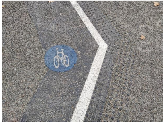
Detalle de las bandas podotáctiles de separación del carril para vehículos. La señal circular de la bicicleta azul denota la posibilidad de estas de circular en todas direcciones (Chaves Vargas, 2021, p. 115)
