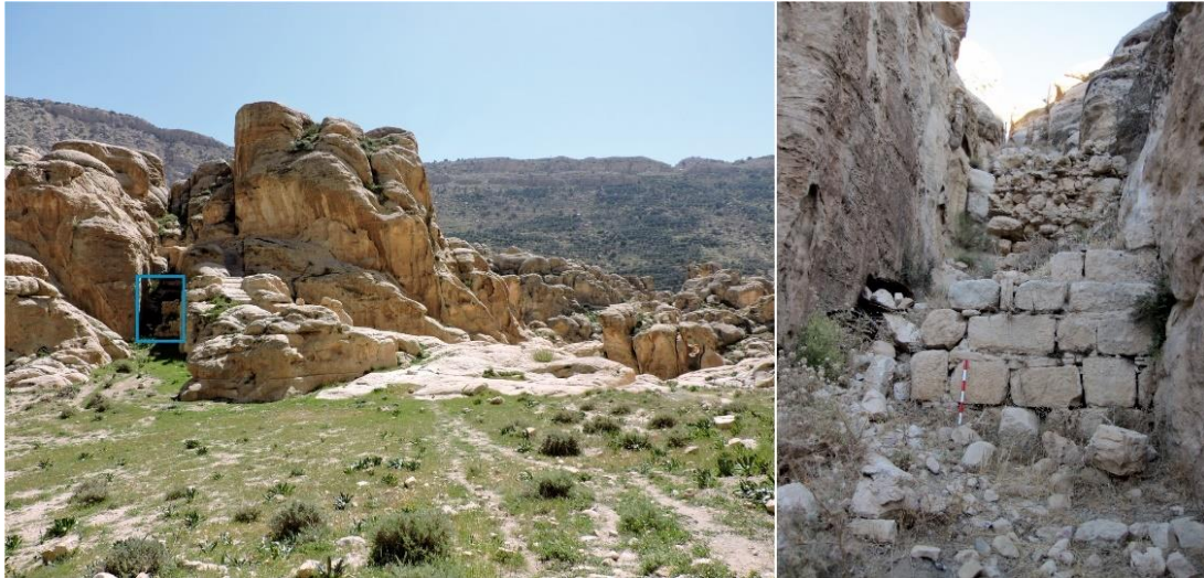
Figura 6.121. Muro de la represa ubicada en el Wadi Hirsh (izq.) y detalle del mismo (dcha.). Fotografías: Proyecto Arqueológico de Sela (izq.: modificada por la autora).
