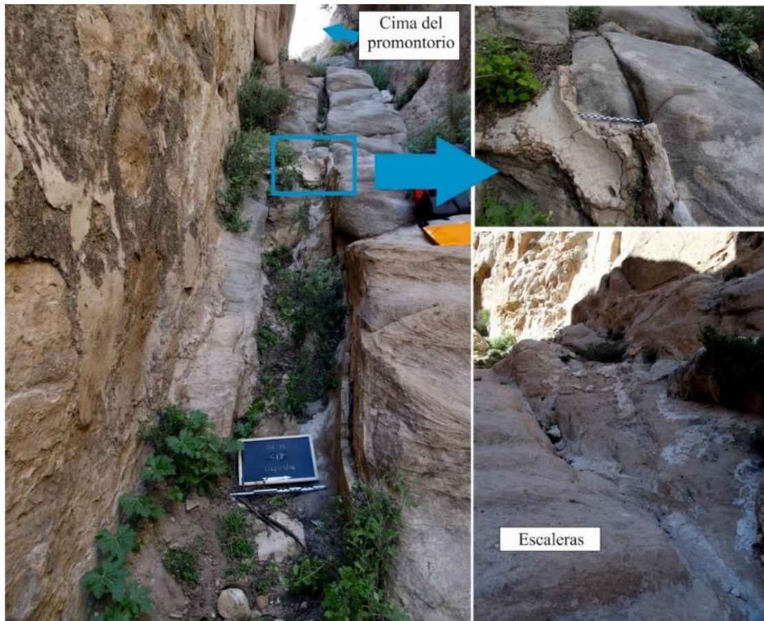
Figura 10.12. Canal C17. Izq.: vista desde el tramo inferior conservado a la cima del promontorio, donde se indica el grosor del mortero. Arriba a la dcha.: detalle del mortero. Abajo a la dcha.: restos del canal y del mortero hasta que se pierde su pista.
