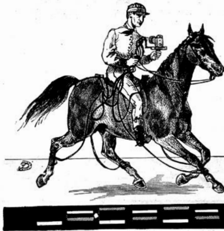
Fig. 75. Cheval portant aux quatre pieds des explorateurs des appuis; le cavalier tient l'appareil inscripteur du rythme des allures.
