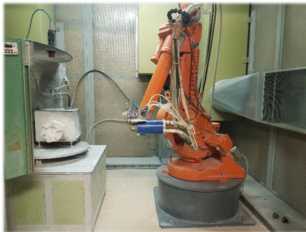
Figura 48. Cabina de proyección con sistema de extracción de gases y pistola de proyección térmica por plasma junto al robot IRB 1400.
