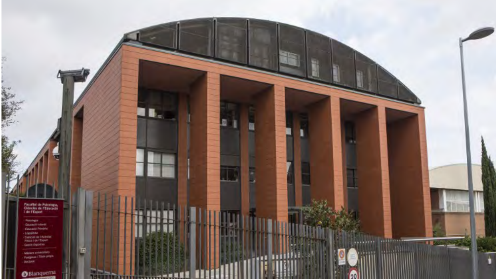
Foto 42: Entrada principal. FPCEE-Blanquerna
