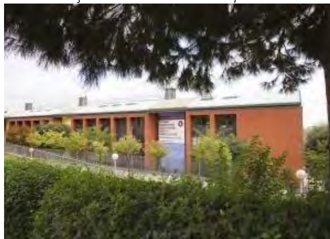
Foto 41: Façana lateral FPCEE-Blanquerna
