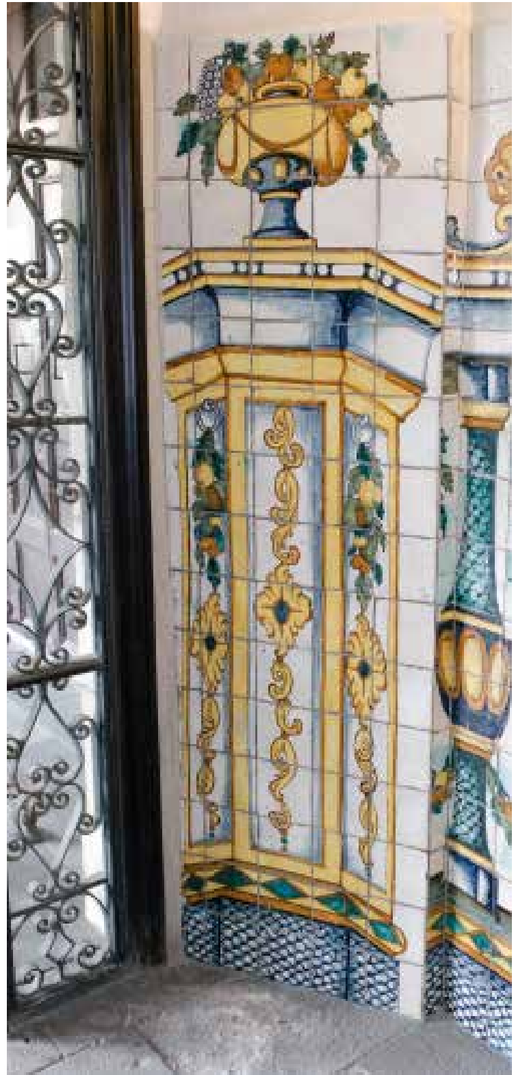
Fig.353: Detall de la balustrada de l'escala. Casa de la Convalecència (Barcelona).
