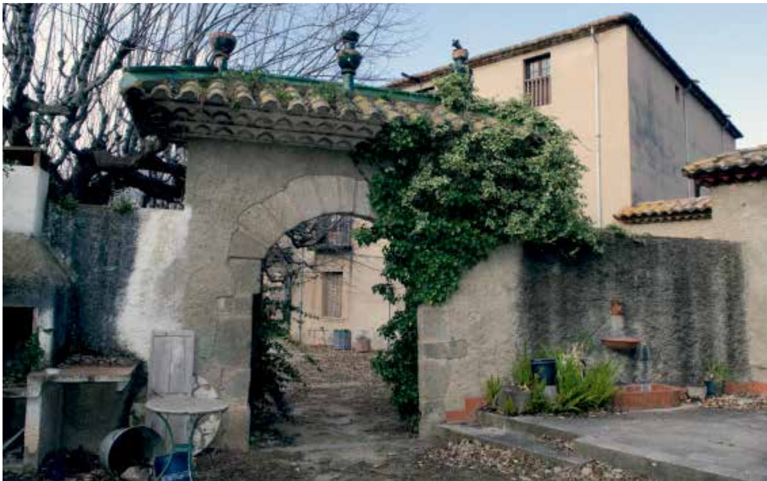
Fig.335: Vista exterior de la masia de Ca Les Monges (Alella).
