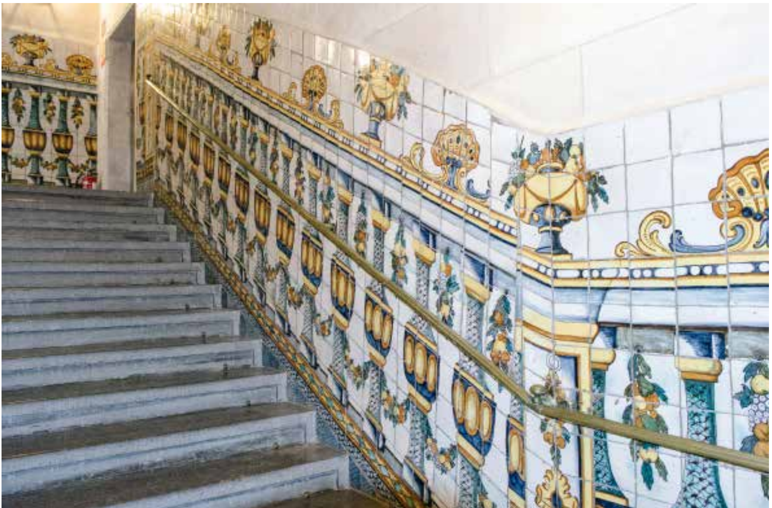
Fig.350: Vista general de l'escala de la casa de la Convalecència (Barcelona), obra de Bernat Reig (1775-1776)
