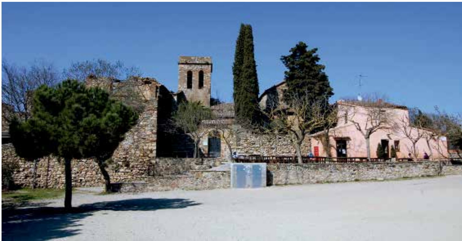
Fig.311: Vista exterior del conjunt de santa Creu d'Olorda (Molins de Rei)
