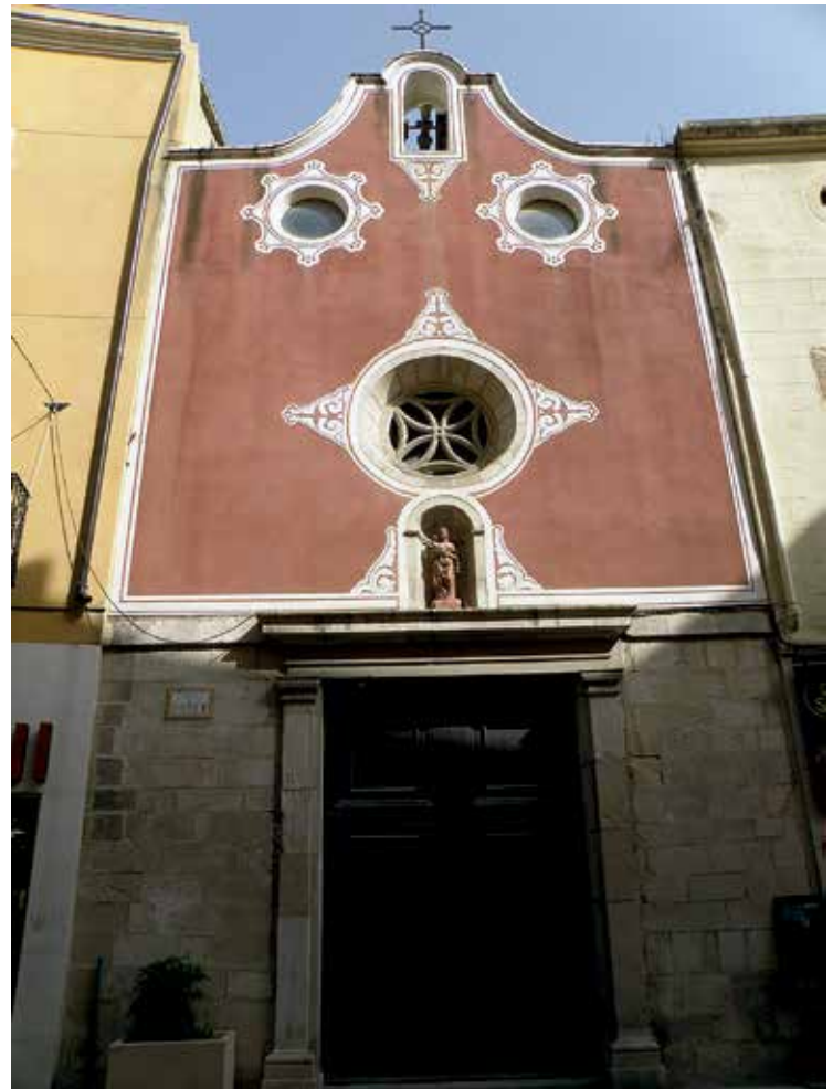
Fig.383: Façana de la capella del Roser (Valls).
