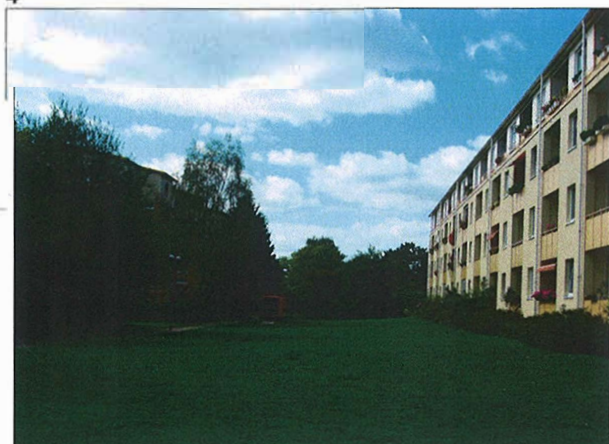
4 Ámbito inmediato de la edificación
