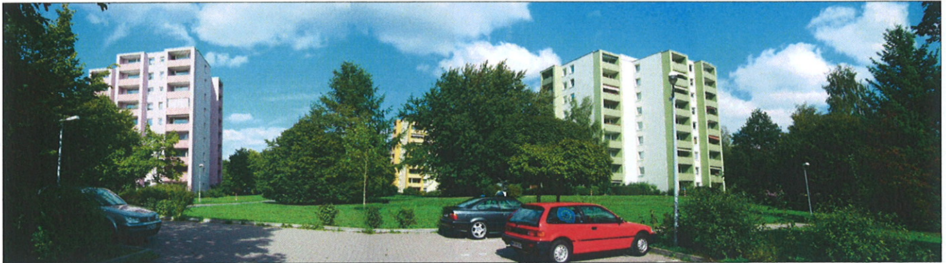
2 Espacio central con edificios en altura
