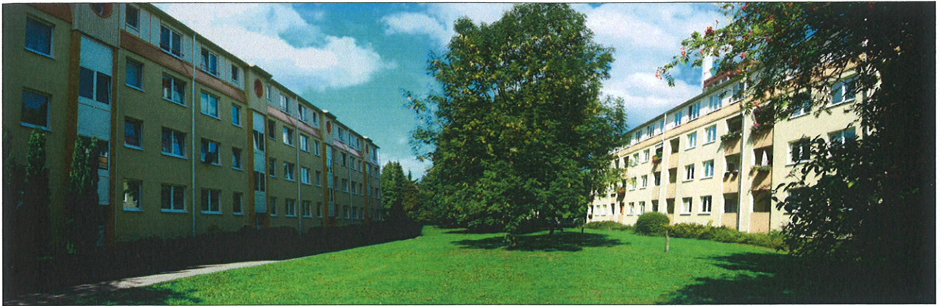
1 Espacio entre barras
