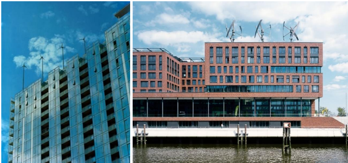
Ilustración 12. Mini turbinas eólicas instaladas en edificios. Fuente: https://www.solaripedia.com/13/297/3330/twelve_west_wind_turbines.html , https://www.bgp.ch/en/news/elbarkaden-receive-eco-label-hafencity-gold
