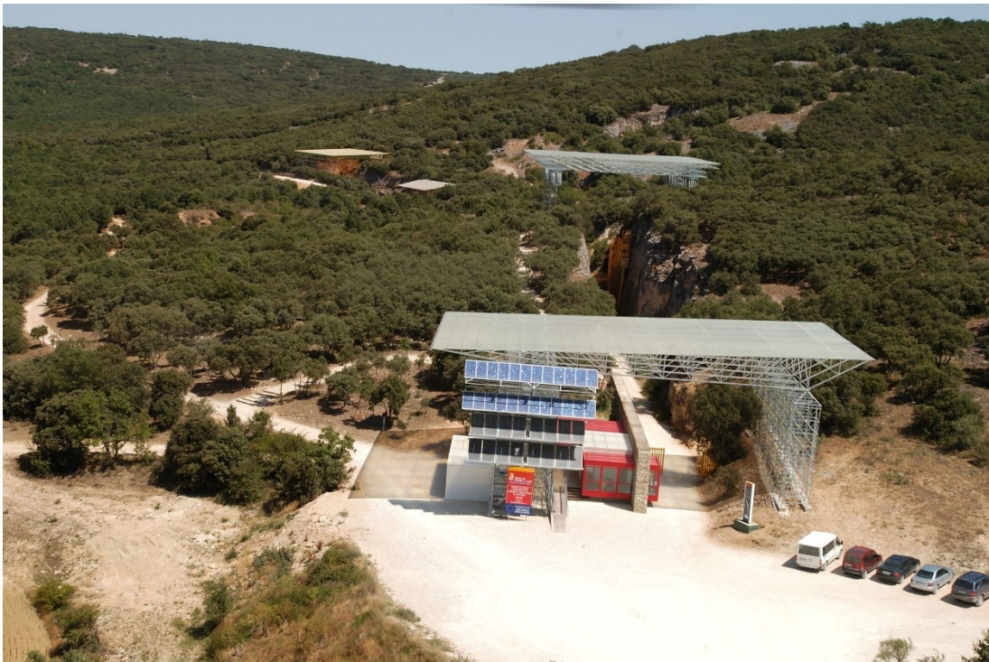
Figura 2.8. Vista de la entrada a la Trinchera del Ferrocarril. (Fotografía: IPHES)
