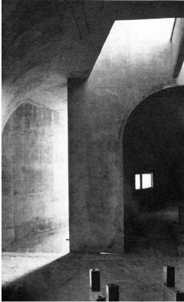
1.3.4.3-9_S-B.d.B. In Nevers Chantier_Mai-juin, 1966_Coques convergentes
