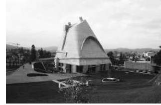
1.3.3.2.3_Eglise de Firminy-Le Corbusier. France, 1971-2006
