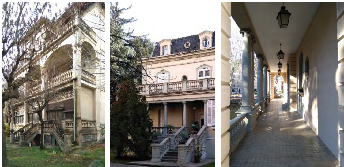
Fig. 53. Alguns exemples de galeries; a l'esquerra la Casa Perandones, al mig la Casa Juncosa i a la dreta la Torre Malagrida. Pròpia.
