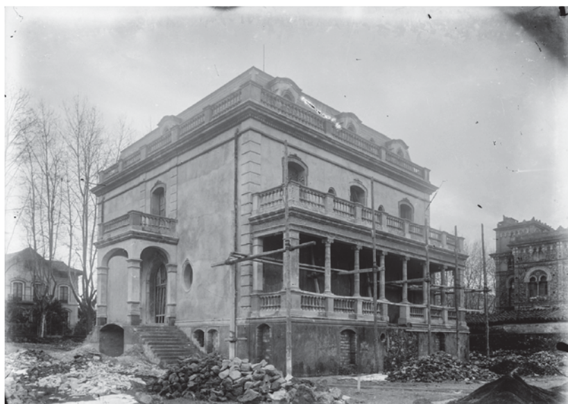
La casa Juncosa en construcció al 1920. ACGAX
