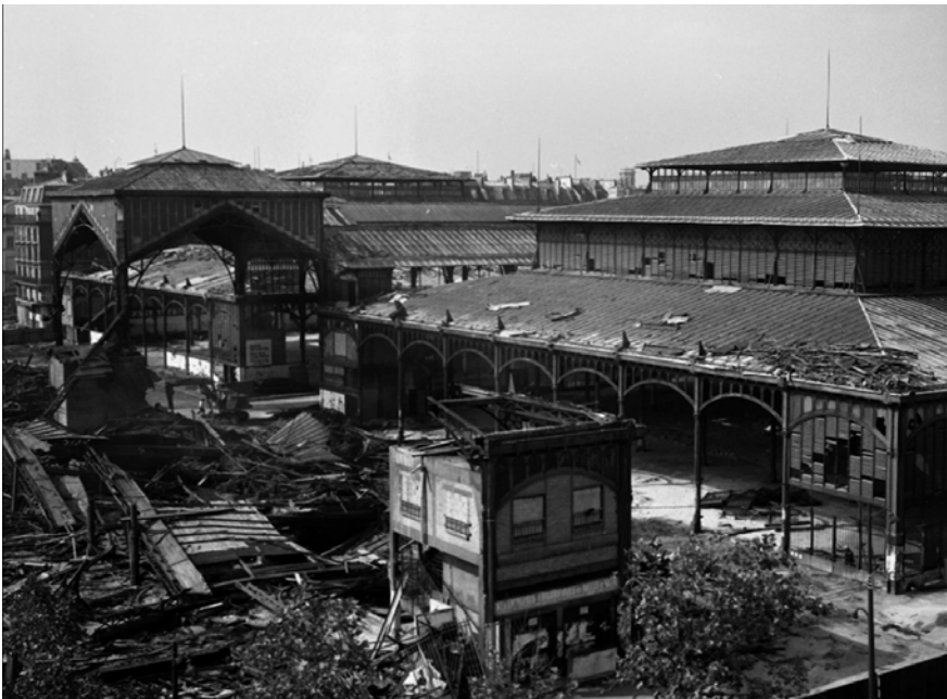
Fotografía 10. Demolición des Halles Baltard. Fuente: René Saint Paul en Libération (2016).
