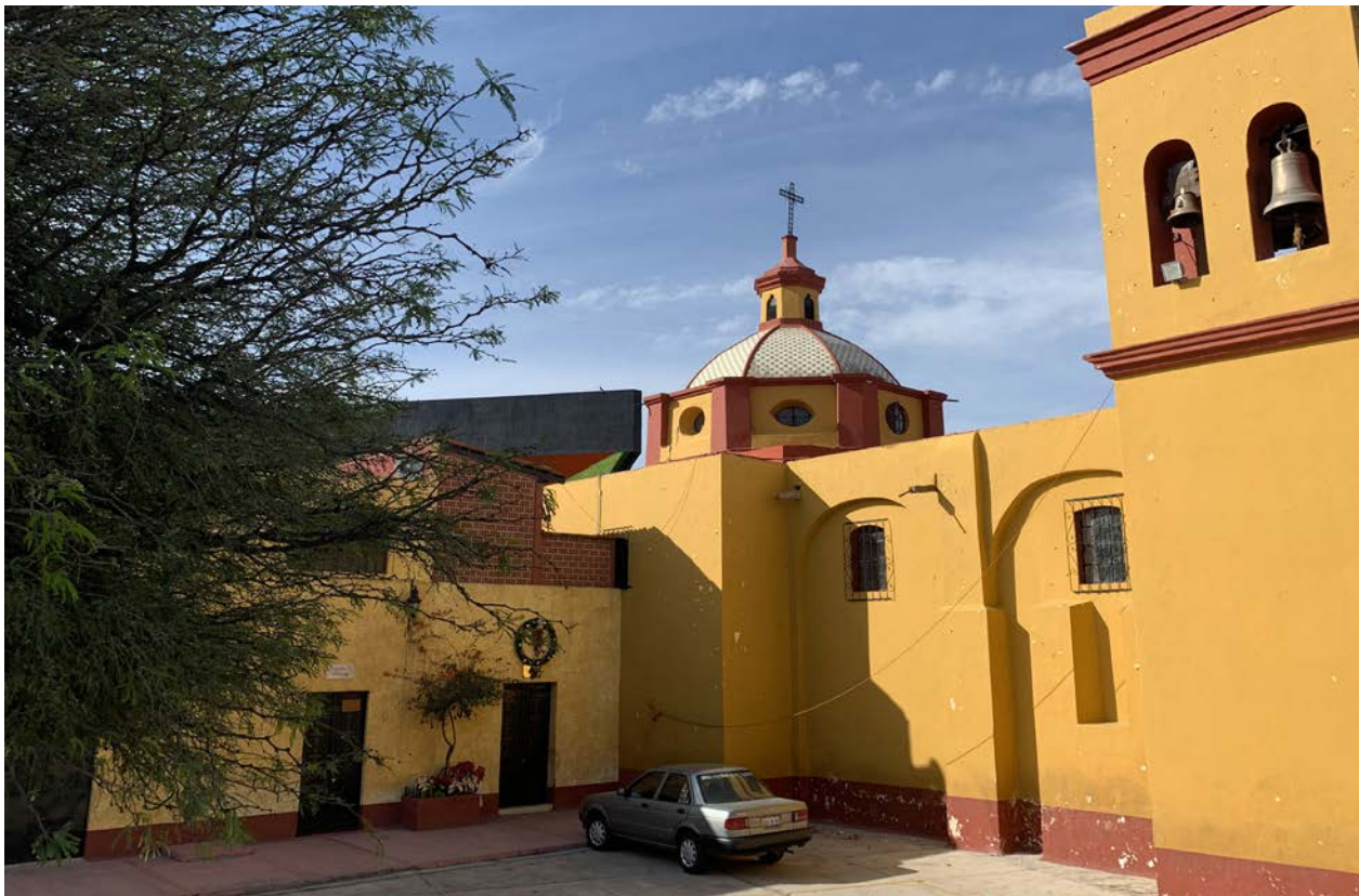
Fotografía 46. Elemento que sobresale del paramento de fachadas, denotando desinterés por el valor patrimonial. Fuente: Archivo personal.
