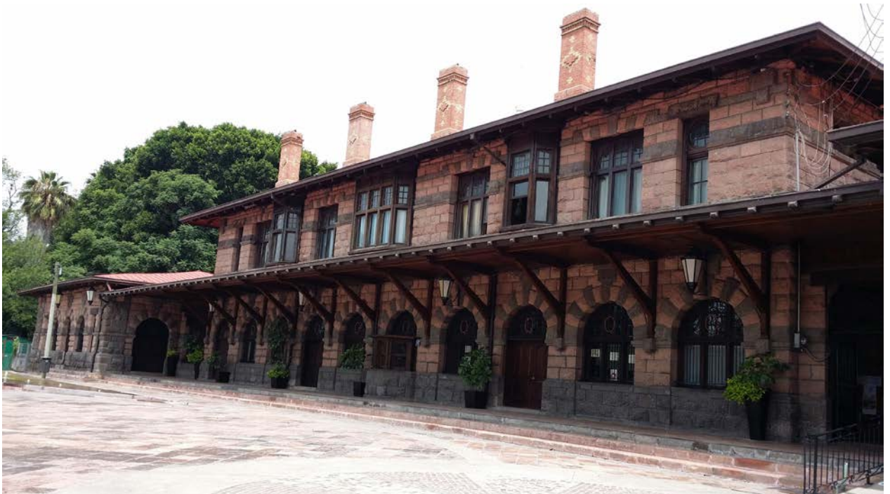
Fotografía 27. Antigua estación de ferrocarril en la ciudad de Querétaro. De estilo inglés inaugurada en 1903. Fuente: AP.
