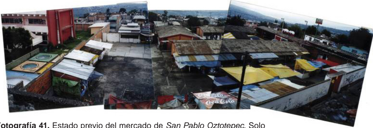
Fotografía 41. Estado previo del mercado de San Pablo Oztotepec . Solo puestos provisionales y lonas. Fuente: redfundamentos (2014).
