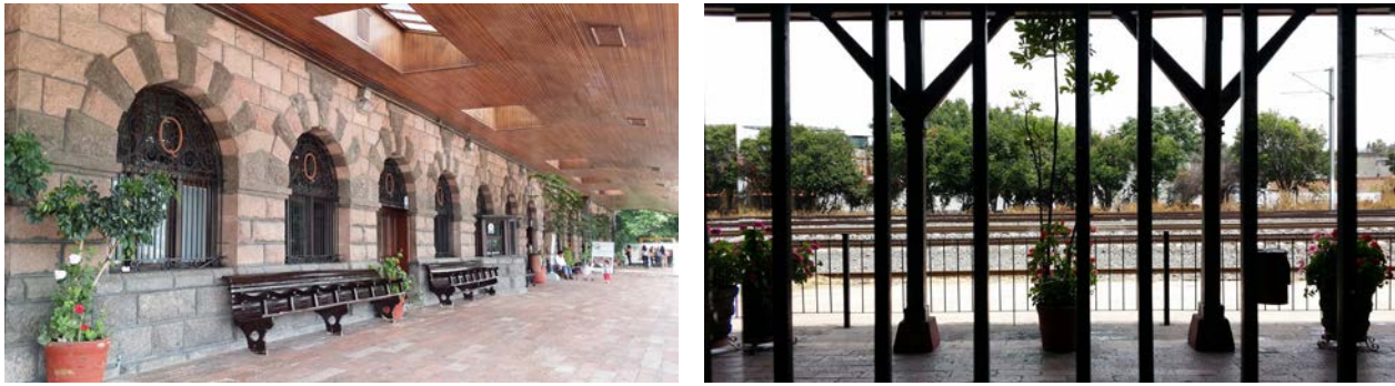
Fotografía 28 (cuadro). Andenes, antigua estación de ferrocarril en la ciudad de Querétaro. Fuente: AP.
