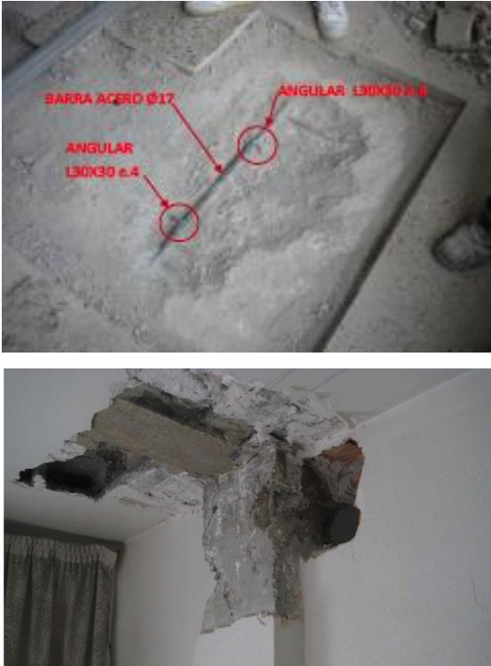
Figura D-1. Cata en viga de primer nivel. Se muestra la barra de acero longitudinal superior y perfiles transversales de las vigas mixtas.
