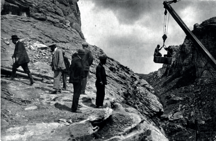
Figura 2. Inspección de obras durante la construcción del embalse de Sant Antoni en Talarn. Se observan los afloramientos de areniscas duras de la Formación Arenisca de Arén. Fotografía de J. Villanueva (ANC), extraída del blog de J.M. Mir: “Quina la fem?”
