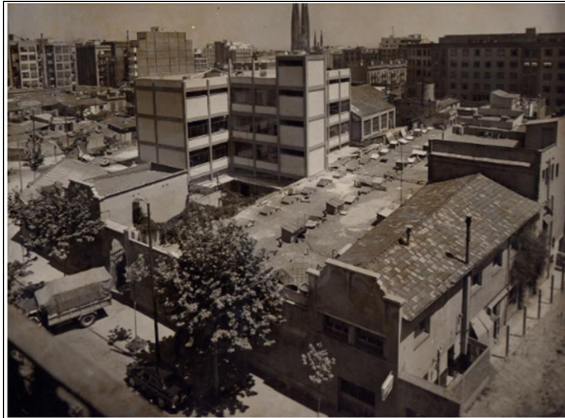
Imatge 5.2: Fàbrica Comptadors de gas Kromschroeder. Carrers Indústria-Sicília-Còrsega. Dècada 1940.
