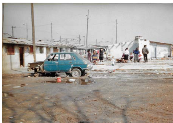
Imágenes 175, 176, 177, 178, 179 y 180. Los últimos derribos, 1986-1989. Fuente: Arxiu Històric del Camp de La Bota i La Mina.
