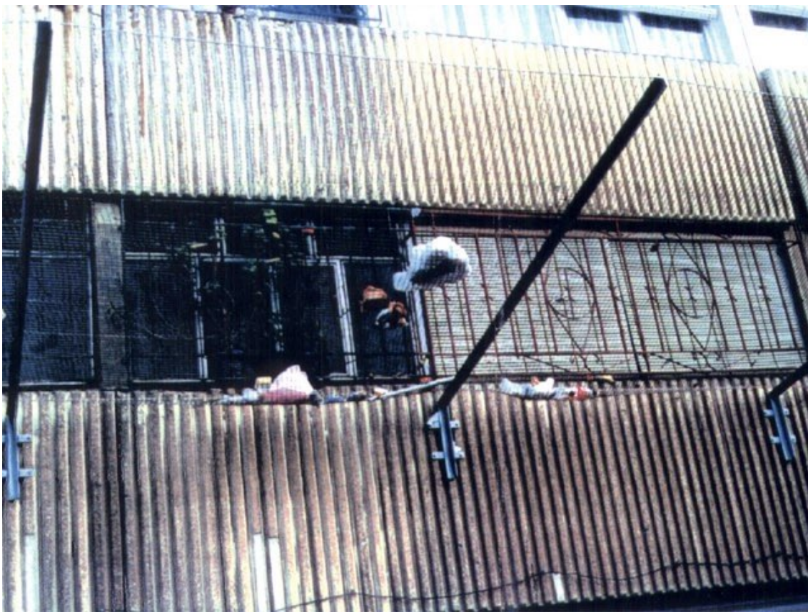
Imágenes 192 y 193. Redes contra desprendimientos, La Mina Nova, década de 1990. Fuente: Arxiu Històric del Camp de La Bota i La Mina.
