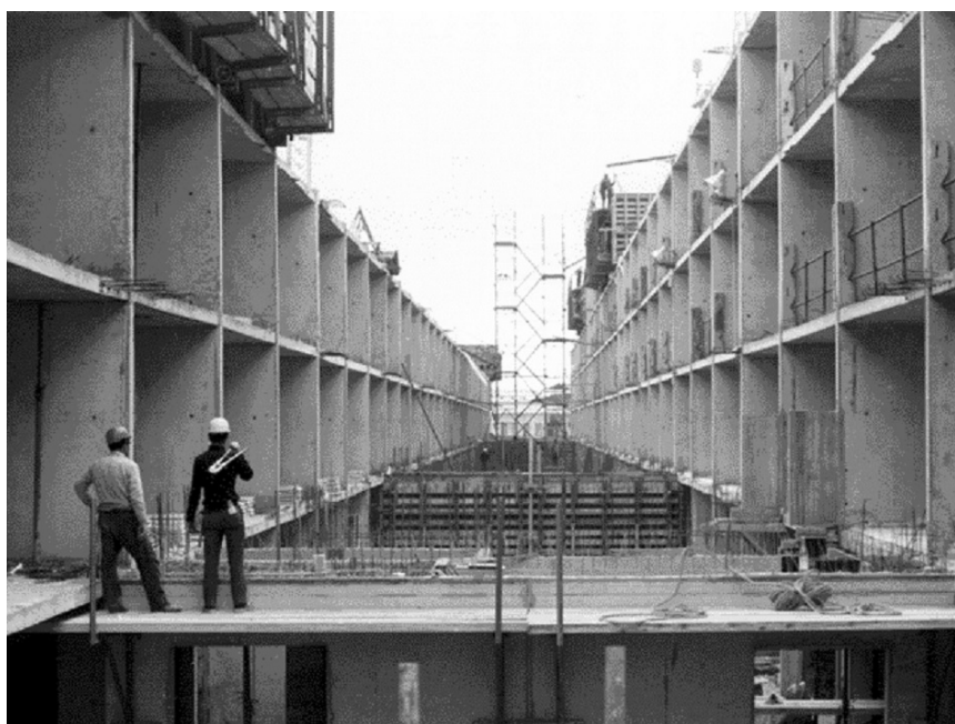
Imágenes 98 y 99. Encofrado tipo túnel, bloques de La Mina Nova, 1972-1974 . Fuente: Arxiu Històric del Camp de La Bota i La Mina .Cedidas por el Patronato Municipal de la Vivienda.
