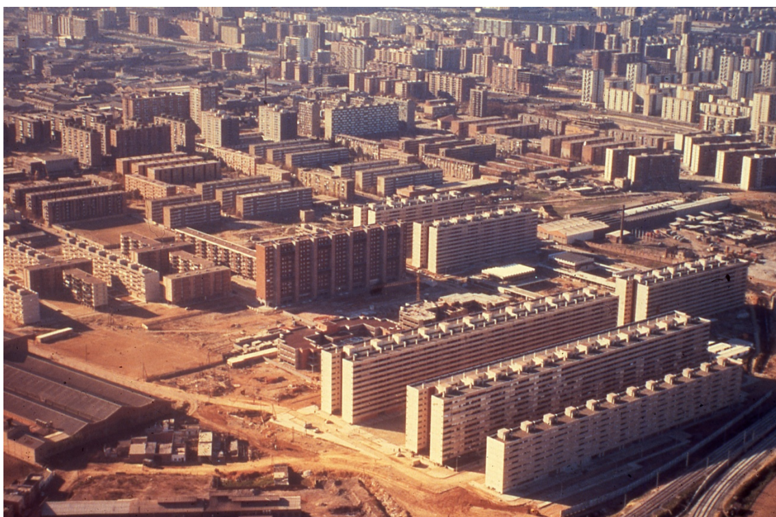
Imagen 103. Vista área desde el este, 1972-1974. Fuente: Arxiu Històric del Camp de La Bota i La Mina .Cedidas por el Patronato Municipal de la Vivienda.
