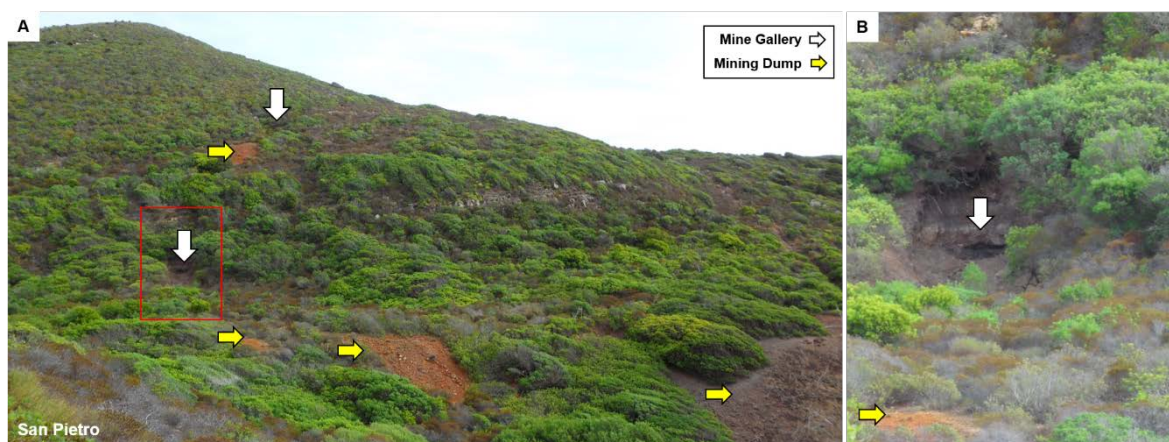
Fig. 11.1: Sector de Mina Capo Becco. A) Vista general con la situación de escombreras y galerías de extracción derrumbadas. B) Detalle en el recuadro rojo de la fotografía A, el diámetro aproximado de la abertura no supera el metro.
