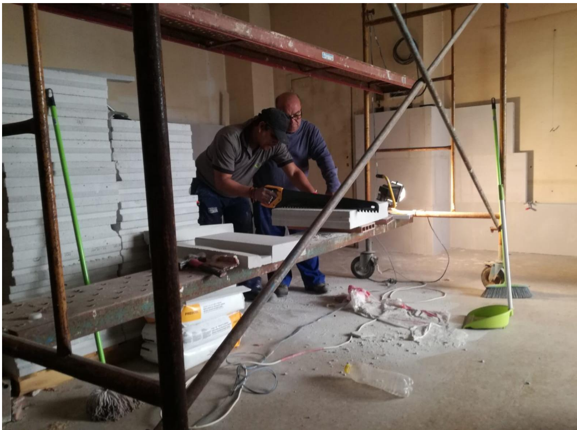
Foto 6. Erick mostrándole a Pedro como cortar las losas. Fuente: foto propia
