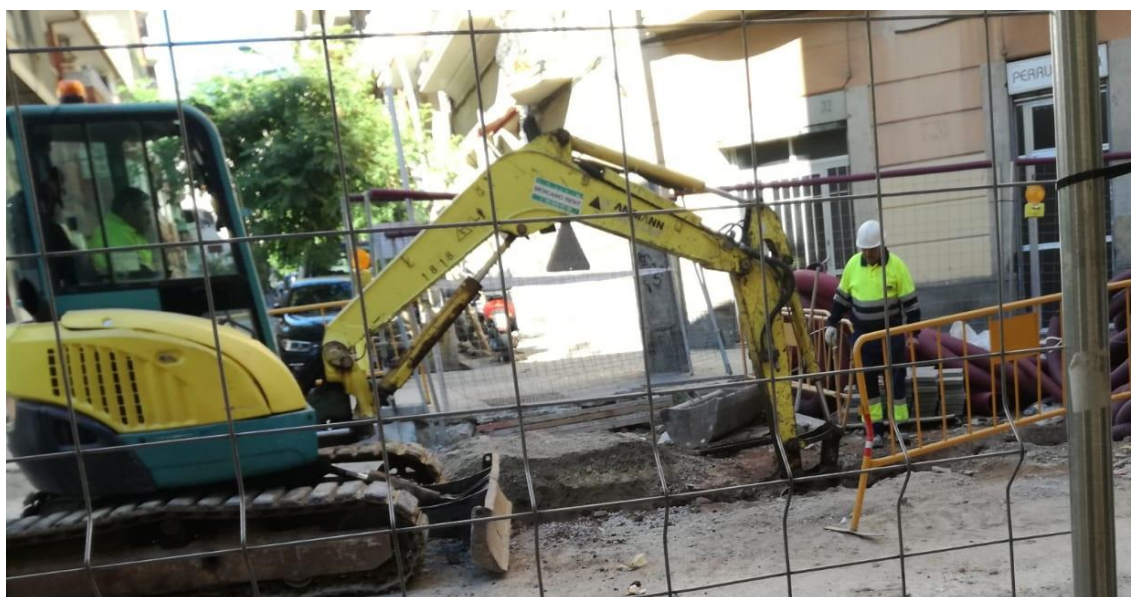
Foto 1: Trabajador de la empresa adjudicataria dando indicaciones a un conductor de la subcontrata de movimiento de tierras. Fuente: foto propia.
