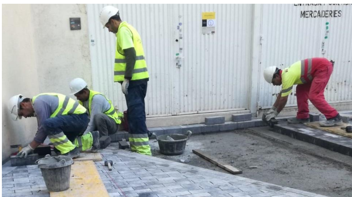
Foto 4. Obreros colocando adoquines. Fuente: foto propia.
