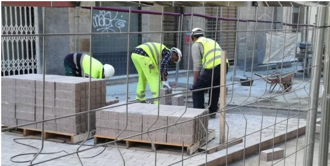
Foto 2: Trabajadores de la empresa cedente de mano de obra colocando adoquines. Fuente: foto propia.
