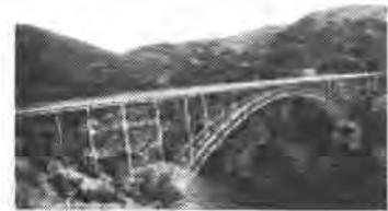
Aunque el interés del viaducto va más allá. El ingenio de Ribera no fue sólo diseñar un arco formado por dos vigas de celosía Pratt con un peso de hierro de 414 kg/ml, frente a los 6.000 y hasta 9.000 de los puentes de Eiffel; además este arco estaba articulado en sus extremos.
