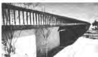
Las pilas son mixtas, de acero Corten y hormigón y están constituidas por marcos huecos cuadrados de 5 x 5 metros de perímetro exterior y 4 x 4 metros de perímetro interior. Tanto sus elementos horizontales como verticales están constituidos por elementos prismáticos de sección rectangular de 0,9 x 0,5 metros.
