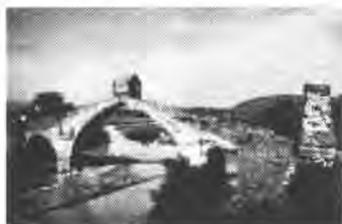
recto con el eje del puente-. La oblicuidad, sin embargo, es pequeña: sólo trece grados. Es probable que el constructor recurriera a ello por la necesidad de situar convenientemente sus cimentaciones en el lecho del río, donde las corrientes y el suelo hicieran más fácil la construcción»<sup>5</sup>.
