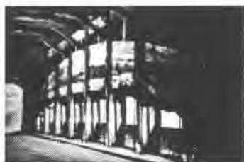
De esta forma, su resistencia a tracción aumenta. Un ejemplo de este tipo de ensamblaje de la madera lo encontramos en un puente construido en 1839 en Signan sobre el río Emmer, en el distrito de Berna. Tiene dos arcos de soporte contruidos con todo detalle como en el dibujo de Leonardo.
