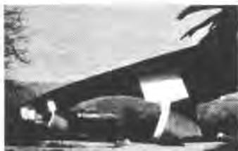
Dos únicos materiales forman la estructura del puente: el hormigón blanco y el acero tipo Corten. El hormigón blanco de pilas y estribos enmarca los elementos longitudinales de acero color siena oscuro, que son las vigas cajón, impostas y barandillas, organizando un juego de alternancia estructural y estética entre ambos materiales. En definitiva, el cromatismo de los materiales como expresión diferenciadora de funciones.
