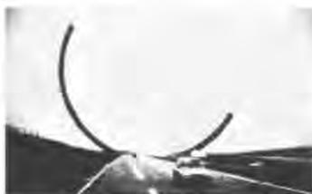
La propuesta de la figura - **Arc Majeur de 185,4°**, de 1986, es un proyecto para la autopista A6, en la frontera entre Nemours y Auxerre, en Yonne, Francia. El arco de acero, inclinado con relación a la línea del horizonte, permite que la autopista pase entre sus dos brazos, uno de 53 metros de alto y el otro de 15 metros.
