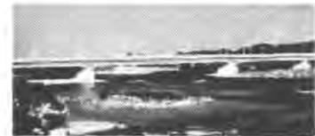
En cuanto a tecnología, este puente presenta características que le confieren una cierta singularidad. A las ventajas que derivan del pretensado exterior, se unen las que derivan de la prefabricación en taller, posibilitando la realización y transporte de piezas de gran longitud y también las de formas complicadas con fuertes esviajes<sup>37</sup>.
