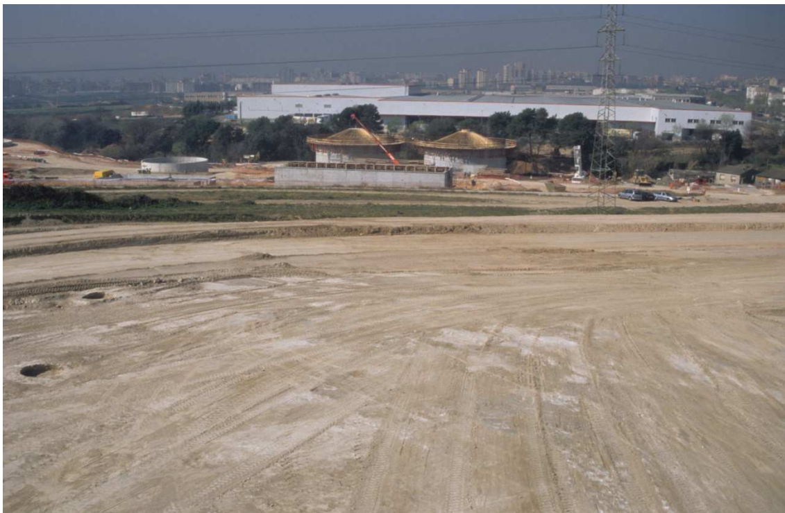
Fig.38.- Construcció de l'EDAR Sabadell - riu Ripoll (1999-2000). Des de Can Roqueta II. Crèdits: Equip CR-II.
