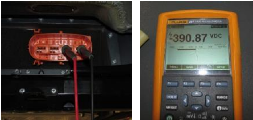
Figura 26. Medición de la tensión de la batería antes de su desmontaje
