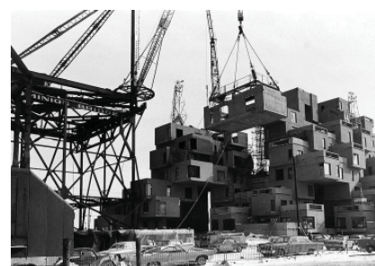
Fig. 2.65. Execució de l'edifici. Mòduls.
