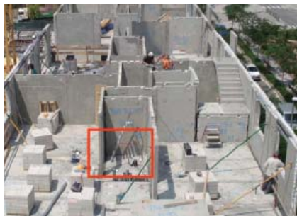
Fig. 2.101. Replanteig instal·lacions.
