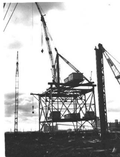
Fig. 2.64. Execució de l'edifici. Estructura base.
