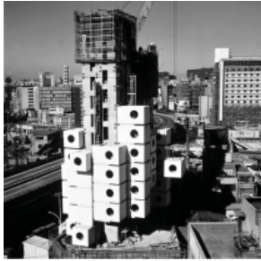
Fig. 2.46. Procés de construcció.
