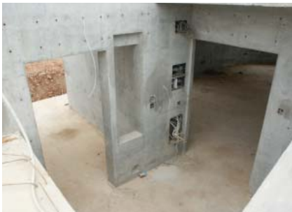
Fig. 2.106. Exemple d'execució d'un edifici.
