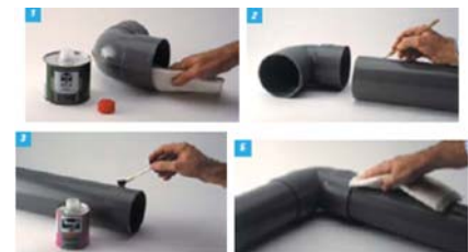
Fig. 4.58. Connexió Adequa Uralita.
