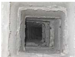
Fig. 2.76. Interior del Shunt .
