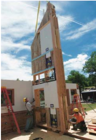
Fig. 2.84. Posta en obra del mechanical core wall .
