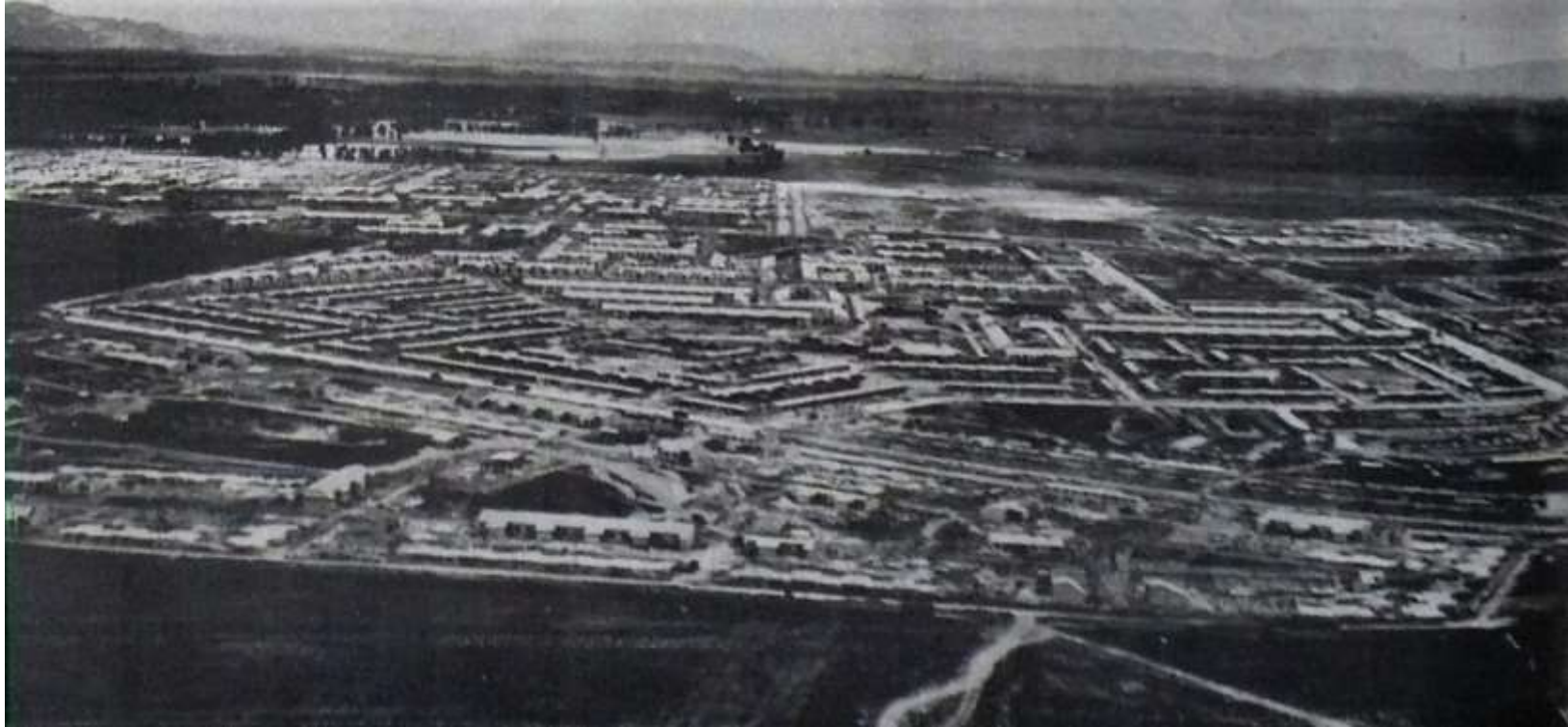
Figura 208. Urbanización Techo, Bogotá 1962 (posteriormente barrio Kennedy).
