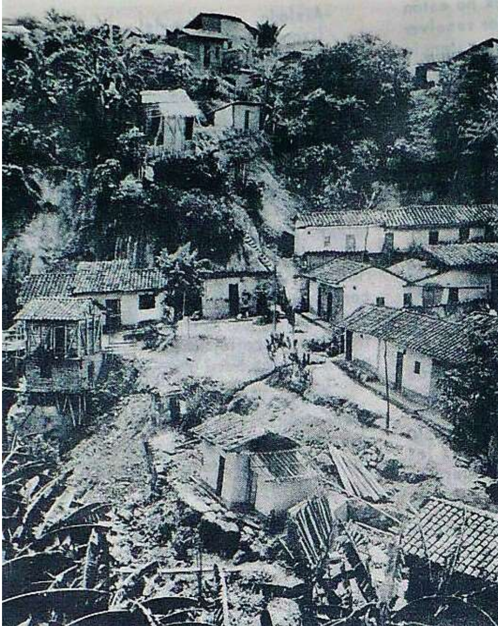
Figura 153. Agrupamiento de viviendas SILOE.
