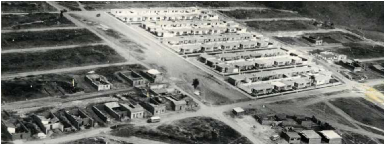
Figura 120. Vista aérea barrio Álvarez Restrepo, Bucaramanga – ICT. Fuente: Archivo Urbanas, cortesía Néstor Rueda
