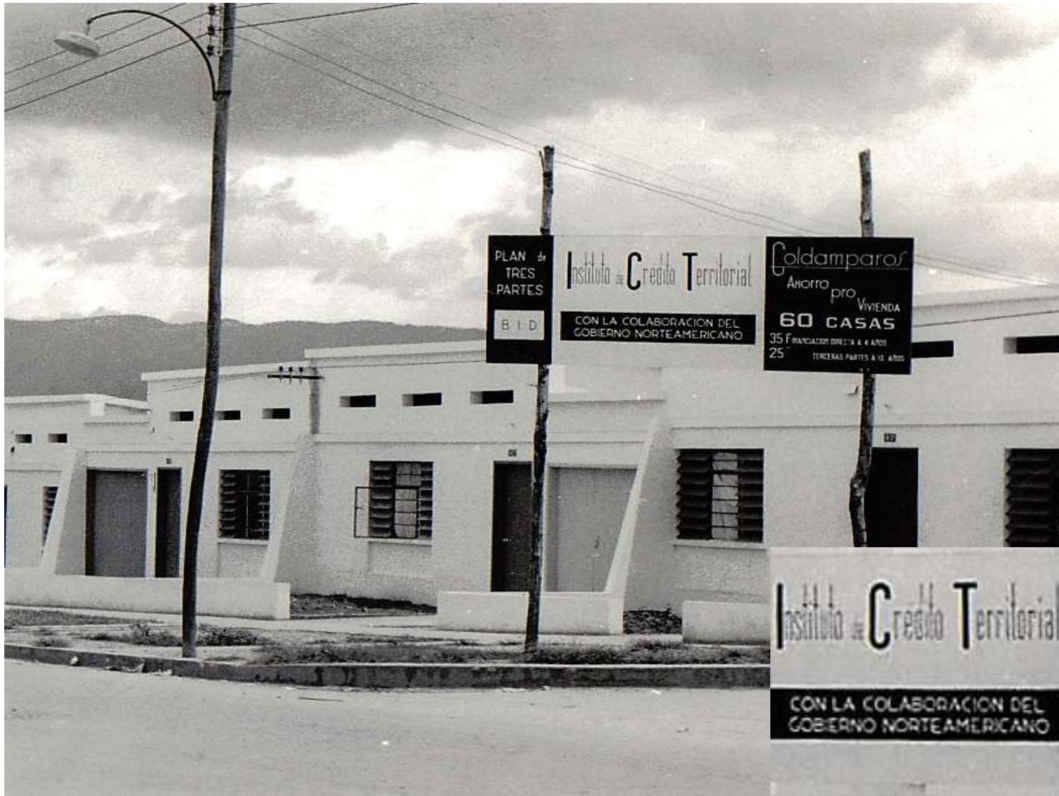
Figura 175. Tipologías 7, 8, y 9 de viviendas, barrio “La Victoria”. ICT, Etapa construida por Coldamparos y la colaboración del Gobierno norteamericano. Fuente. Archivo Fotográfico ICT, Cortesía Néstor Rueda.
