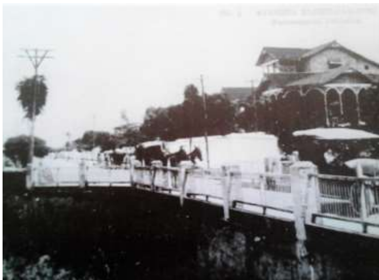
Figura 6. Puente Camacho, en la Avenida Eliseo Camacho Carreño, antes de su ampliación. Fuente. Fotografía italiana de Quintilio Gavassa 1878-1958.
