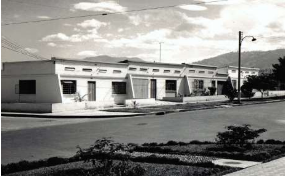
Figura 184. Vivienda Tipo 7, 8 y 9 barrio La Victoria 2ª Etapa Coldamparos. Fuente. Archivo ICT, Cortesía Néstor Rueda.
