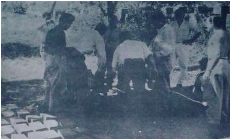
Figura 165. Becario del Cinva y alumnos de la escuela normal produciendo bloques. Fuente. La vereda de Chambimbal, Estudio y Acción en Vivienda Rural. Ed. Vautier & Fals Borda. Centro Interamericano de Vivienda y Planeamiento. Servicio de Intercambio Científico y Documentación. Bogotá, D. E. 1958, pp. 105-115.
