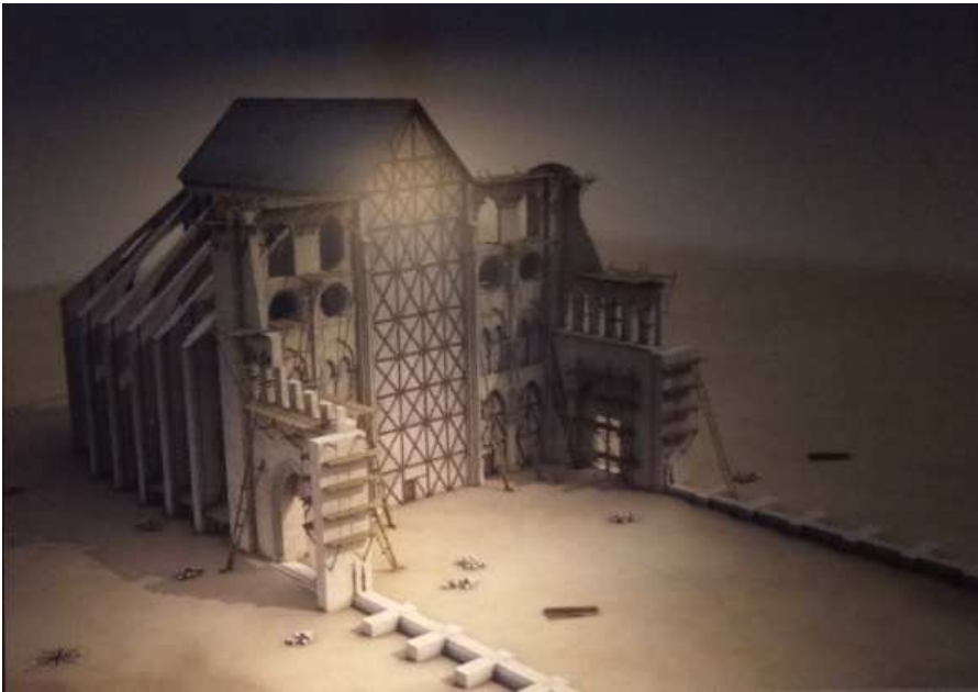
Ilustración XIII: El fin de las obras del coro y la construcción del tabique provisional
