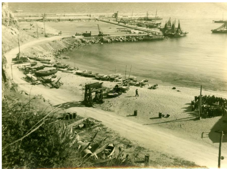
Figura 2.15: Las obras del puerto de Blanes en 1918. Fuente: AMBL
