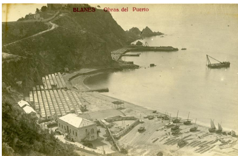
Figura 2.16: Obras de construcción del puerto de Blanes en 1918. Fuente: AMBL
