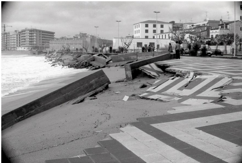
Figura 2.24: Daños en el paseo de s'Abanell en 1985 después de un temporal. Fuente: AMBL
