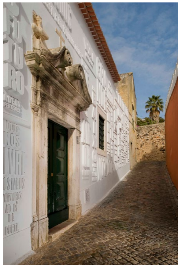
Fig. 9.74 Vista geral da fachada após intervenção. Autoria: R2. (Fonte: © Fernando Guerra, 2008)
