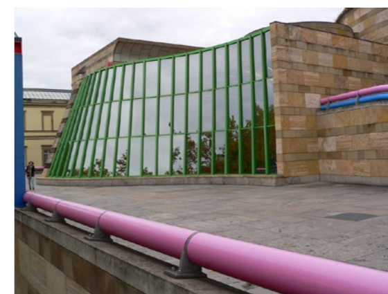
Fig. 4.8 Fachada do Neue Staatsgalerie (Estugarda). (Fonte: Kroll, 2011, s.p.)
