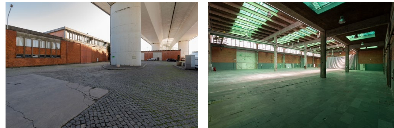
Fig. 10.60 Vistas (exterior e interior) do CACE Cultural do Porto, futura Extensão da Indústria. (Fonte: © António Alves/MdC, 2020)
