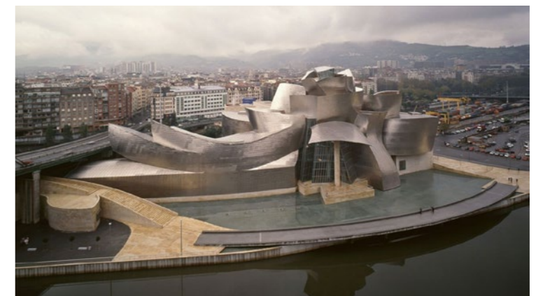
Fig. 4.10 Vista aérea do Guggenheim Bilbao. (Fonte: Mendelsohn, 2017, s.p. © David Heald, 1997)
