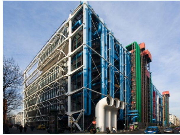
Fig. 4.5 Componentes internas exteriorizadas no Centre Pompidou. (Fonte: Rogers Stirk Harbour + Partners, 2015, s.p.).
