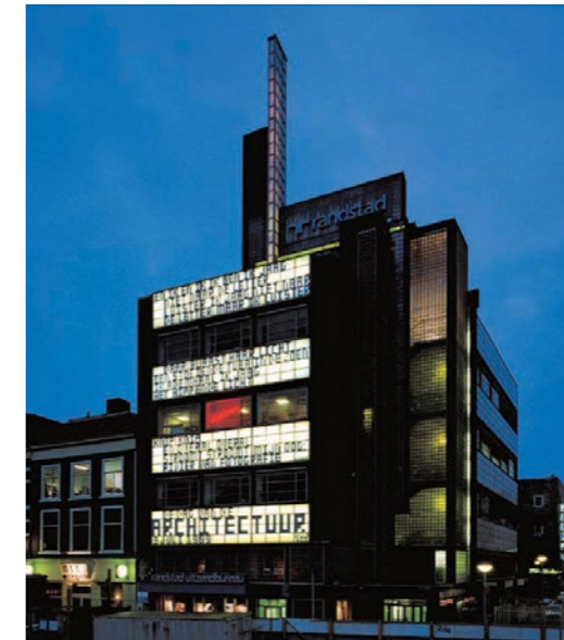
Fig. 9.8 Projecto de intervenção tipográfica na fachada do edifício da Volharding Cooperative, desenvolvido pelos Lust em 1998. Os designers utilizam as fontes LUSTPop e a Citizen (da autoria de Suzanna Licko), nos painéis de vidro que cobrem a fachada, conectando o movimento De Stijl (do início do século XX) às fontes bitmap . (Fonte: Elliman, 2001, p. 62)
