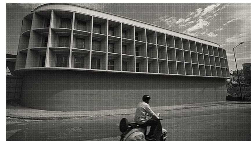
Fig. 10.13 A malha quadriculada que compõe a fachada do edifício. (Fonte: © R2, 2018)
