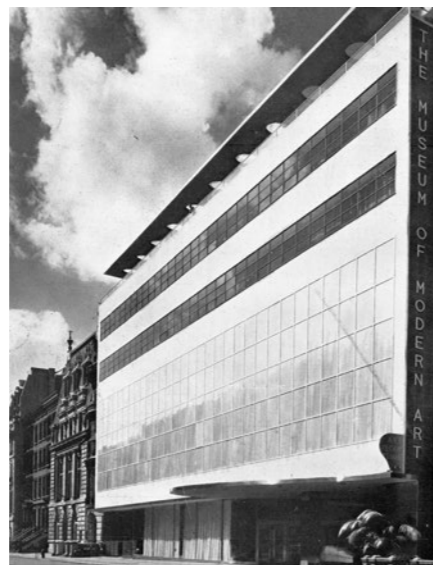
Fig. 4.1 Aplicação da designação na lateral da fachada. (Fonte: Art D'aujourd'hui, 1950, p. 16)
