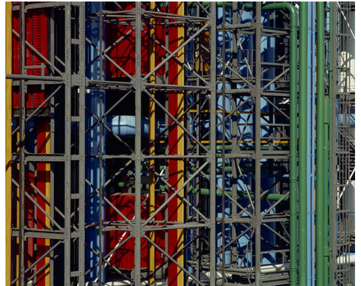
i. 373 Detalle de la fachada este
