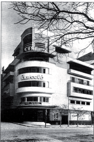
El cine Barceló, en Madrid, construido por Gutiérrez Soto en 1930.
