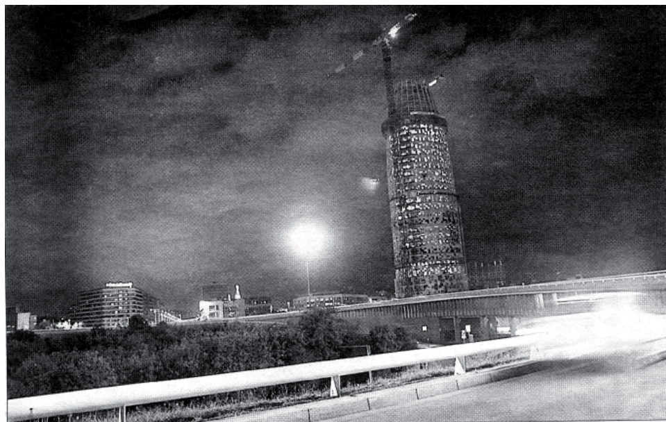
El nuevo Monoolv debería incluir en su tablero edificios de nuevo cuño como la Torre Agbar. / JOAN SÁNCHEZ
