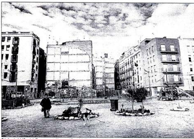
Estado actual del Pou de la Figuera —conocido como el Forat de la Vergeonya—, uno de los espacios que se reurbanizarán en Santa Caterina. / JONAS GUERRERO
