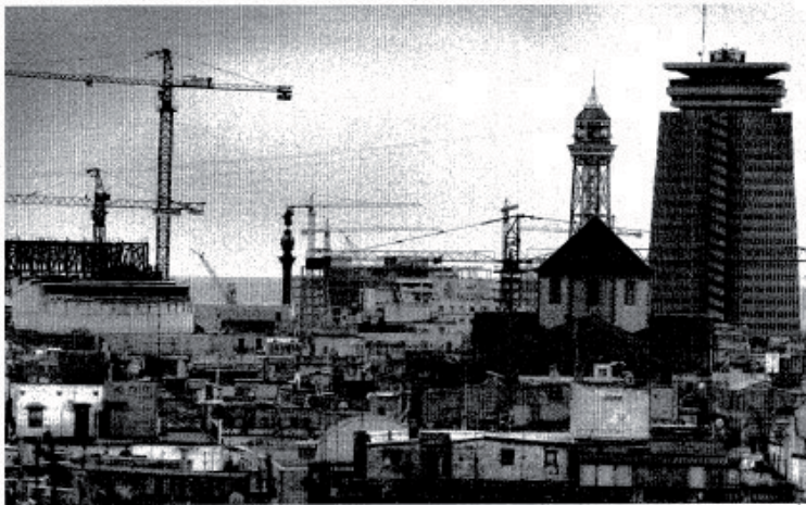
En los últimos años Barcelona se ha convertido en un laboratorio de construcciones no siempre estéticamente arduosas
