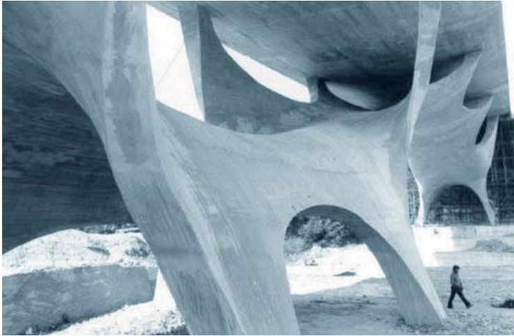
Pont a Basilicata, Potenza (Itàlia)
