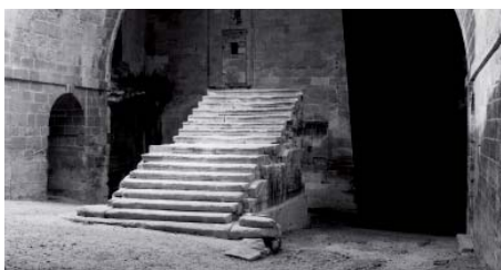
Stair case to above, fotogràf desconegut Humberto Ribas, Montmajou
