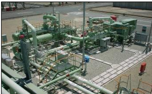
(c) Himeji LNG Terminal (Osaka Gas Co., Ltd.) DE unit [80 t-LNG/h, 1.5 MW]
