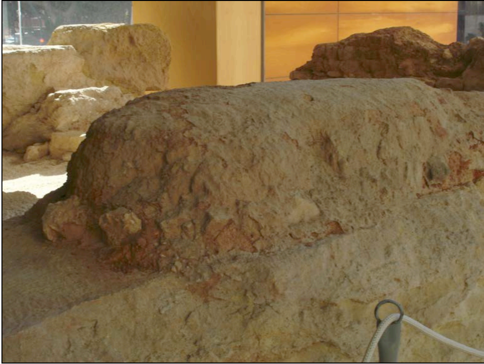
Fig. 131: Fotografía del paramento interior de la muralla de compartimentos de Cartagena donde se pueden observar los adobes descompuestos sobre el zócalo de sillares (Foto S. Lacruz).
