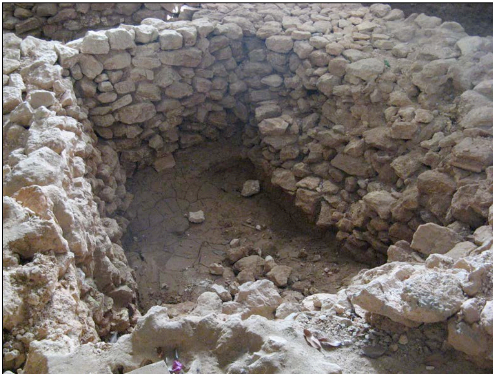
Fig. 186: Fotografía de uno de los cajones que conformaban la muralla de Tavira en su fase II después de su vaciado (Foto autor).
