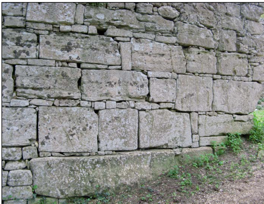
Fig. 169: Fotografía de la Torre 4 de Erice II donde se puede apreciar la existencia de sillares de distintas alturas y calzados con ripios para nivelar sus hiladas que hacen que su aparejo se haya de calificar como rectangular pseudoisódomo (Foto autor).
