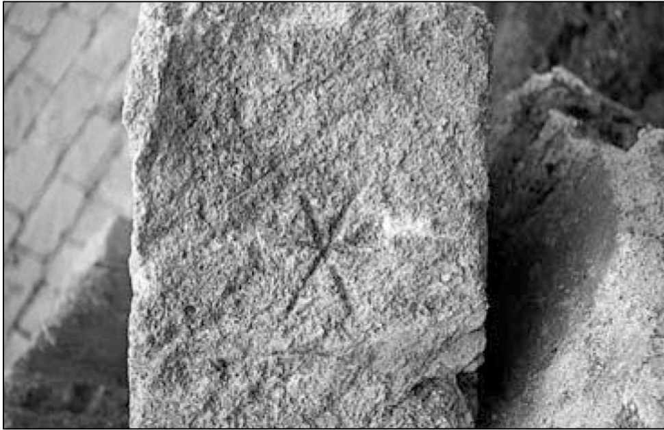
Fig. 177: Fotografía de un sillar de la fortificación de Lilibeo I donde aparece inciso un asterisco de seis puntas interpretado como marca de cantero (Mezzolani, 2009a).
