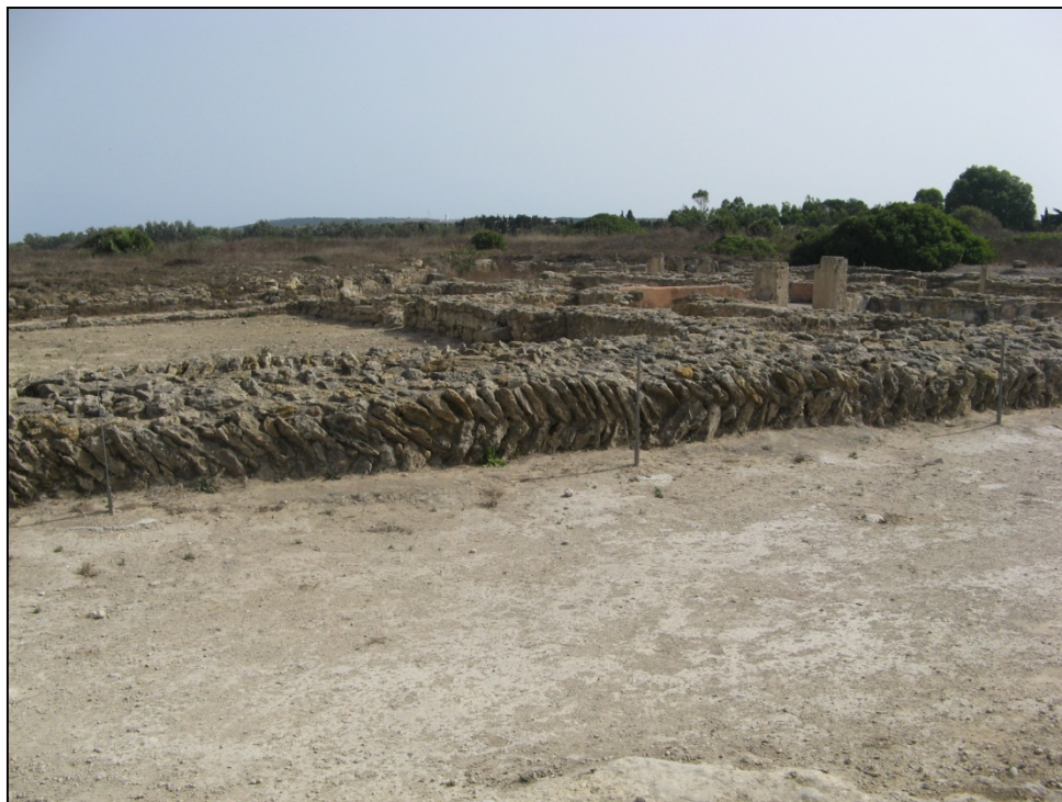
Fig. 154: Fotografía del aparejo en espiga perteneciente a la cimentación de la muralla de la fase I de Kerkouane en su sector norte (Foto auto).
