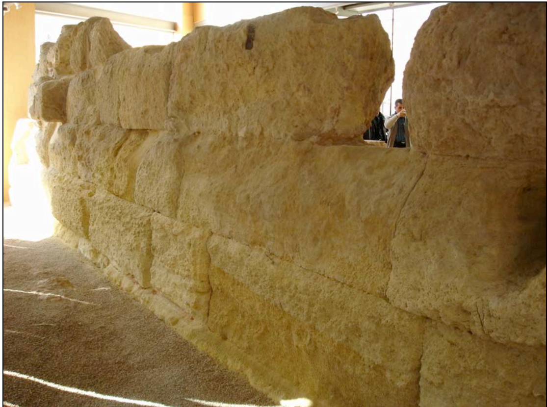
Fig. 171: Fotografía del paramento externo de la muralla de compartimentos documentada en la zona del istmo de Cartagena que emplea sillares biselados de diferentes alturas en su construcción, dando lugar a un aparejo rectangular pseudoisódomo (Foto autor).
