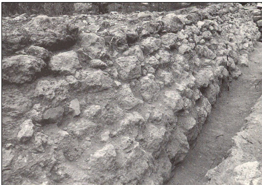
Fig. 26: Refuerzo exterior en talud situado en la cara norte del fortín de Ḥorbat Rosh Zayit (Gal y Alexandre, 2000).
