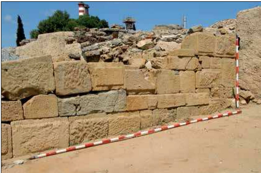
Fig. 174: Fotografía de uno de los muros laterales de la puerta sur de Carteia en su fase II donde se puede reconocer el aparejo rectangular irregular que emplea sillares de diferentes alturas y diversos engatillados (Blánquez Pérez, 2013).
