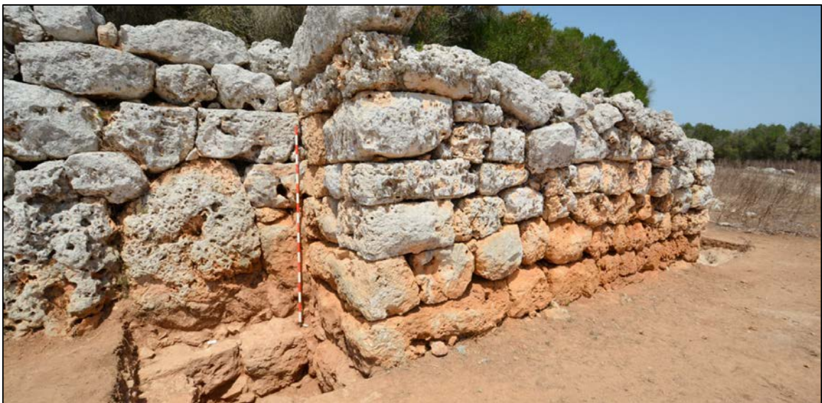
Fig. 172: Fotografía de una de las torres de la fase II de Son Catlar donde se pueden observar los sillares de diferentes alturas situados en una de sus esquinas para dotar de mayor solidez a la estructura (Prados Martínez et alii , 2017).
