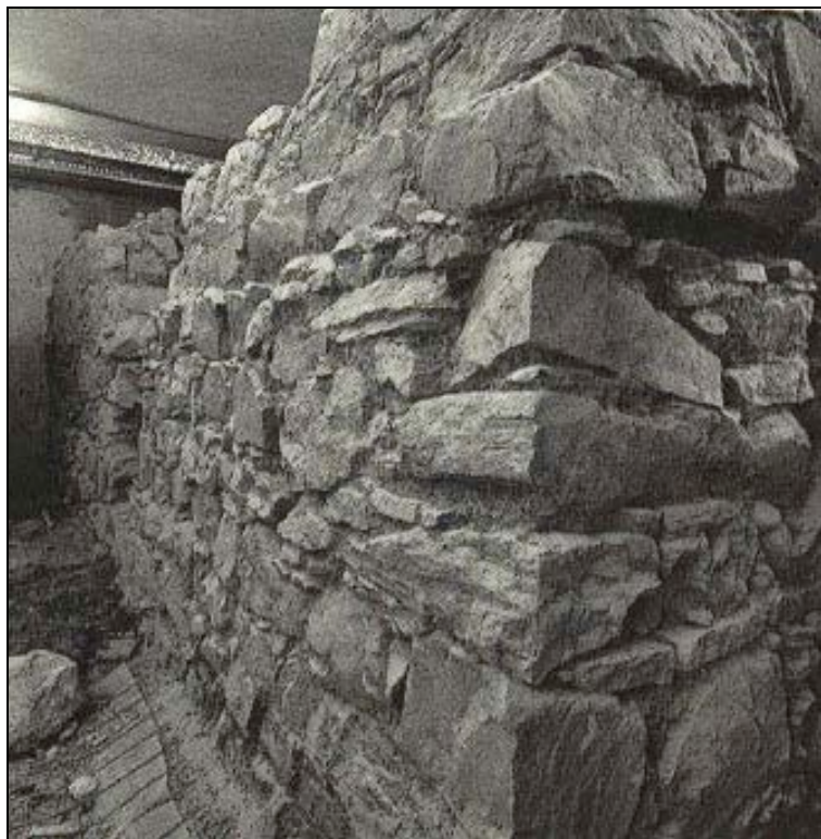
Fig. 142: Fotografía de la mampostería careada calzada con ripios de la muralla de la fase II documentada en el Palacio de Buenavista en Málaga (Corrales Aguilar, 2004).
