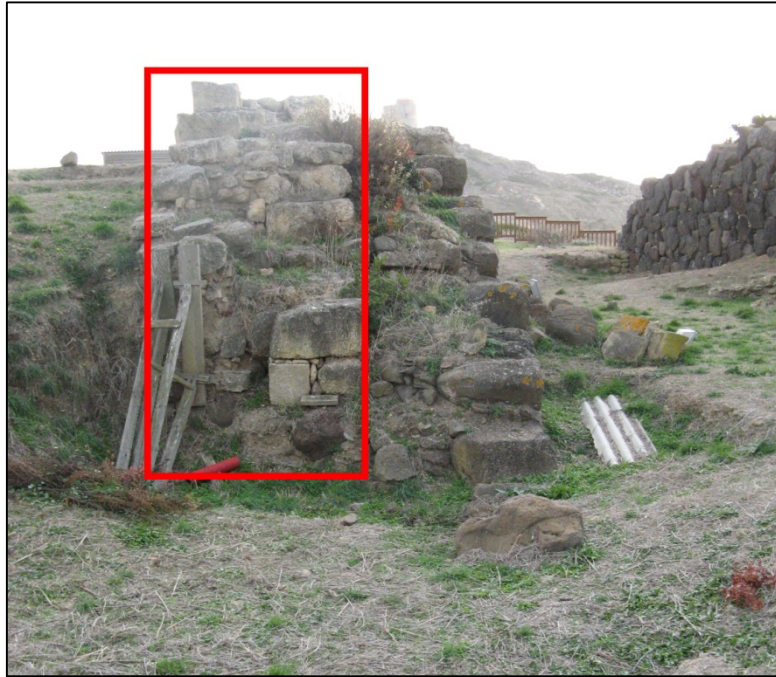
Fig. 185: Fotografía de la muralla del tipo M.0 correspondiente al período P.M. documentada en la colina de Muru Mannu en Tharros señalada con el recuadro en rojo. En ella se puede observar claramente como el muro de basalto de época romana se adosa a su paramento externo (Foto autor).
