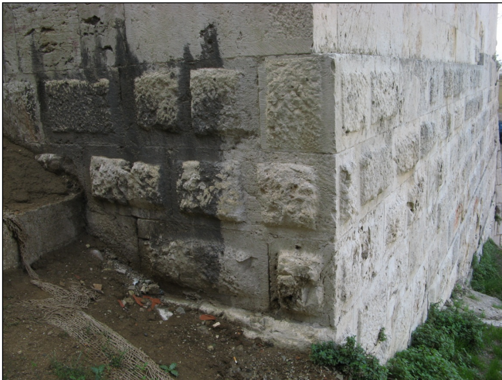
Fig. 72: Fotografía del basamento en aparejo rectangular almohadillado de la torre del Elefante construida durante la ocupación pisana de la ciudad de Cagliari (Foto autor).
