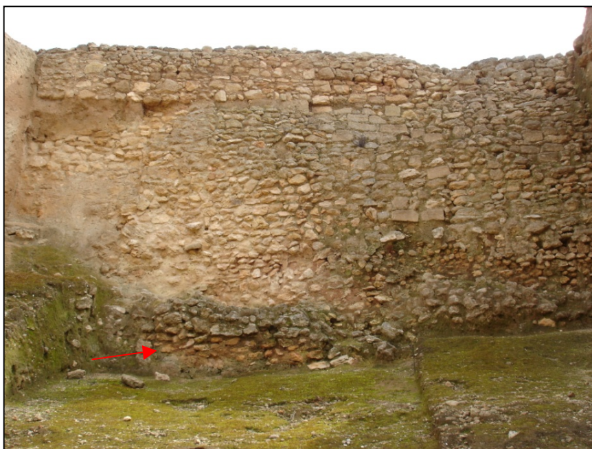
Fig. 136: Fotografía de la muralla del Castillo de Doña Blanca I en su sector norte. En su parte inferior se puede observa -flecha roja- la zapata sobre la que se eleva el paramento exterior de la muralla correspondiente al período A. (Foto S. Lacruz).
