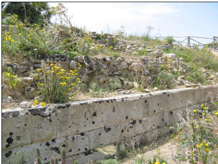
Fig. 163: Fotografía del aparejo rectangular pseudoisódomo de la fase III de las fortificaciones de Mozia en su sector septentrional. En ella se puede observar como el muro de sillares forra por el exterior la parte frontal de una torre bipartita -2- de la fase I (Foto autor).
