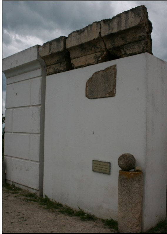
Fig. 129: Fotografía de la reconstrucción del tramo de muralla marítima descubierto en el área arqueológica del barrio de Magón en Cartago. En la parte superior se pueden observar las cornisas de media caña recuperadas durante el proceso de excavación (Foto. F. Núñez).
