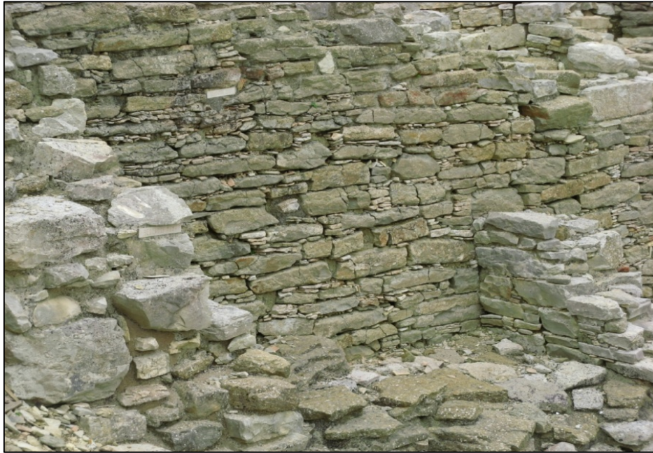
Fig. 153: Fotografía de la mampostería empleada para la construcción de fase I de las defensas de Segesta que presenta grandes similitudes con aquella utilizada en la fortificación de Mozia I (Foto autor).
