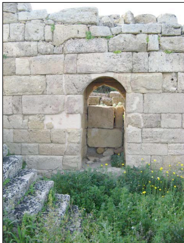
Fig. 58: Fotografía de una de las poternas abiertas en la muralla oriental de Selinunte en época de Hermócrates que presenta una cobertura a falso arco. En primer plano las escaleras para acceder al adarve desde el interior de la fortificación (Foto autor).
