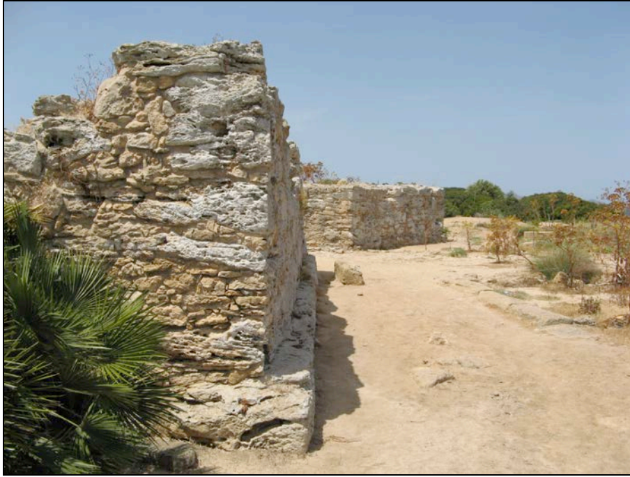
Fig. 239: Fotografía lateral de los dos torreones trapezoidales que flanquean la puerta Norte de Mozia durante su fase IV y cuya forma evita ofrecer un frente plano a la maquinaria de asalto (Foto autor).
