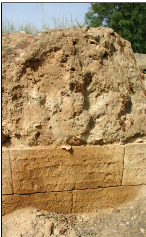
Fig. 53: Fotografía de la supuesta muralla arcaica de Camarina donde se aprecia el zócalo realizado en aparejo rectangular isódomo y el alzado de adobes en descomposición (Tréziny, 2010).
