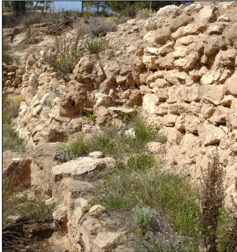
Fig. 147: Fotografía del refuerzo en talud adosado contra el paramento externo de la muralla de La Fonteta II en su sector meridional (Foto S. Lacruz).
