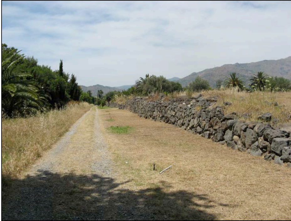
Fig. 51: Fotografía del paramento exterior de la muralla arcaica de Naxos erigida en aparejo poligonal que emplea roca volcanica para su construcción (Foto autor).
