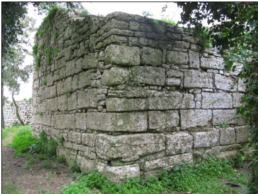
Fig. 162: Fotografía de la Torre 8 de Erice II donde se puede apreciar el uso del aparejo rectangular “isódomo”, tanto en su cara sur como en la oeste, con sillares que mantienen una altura constante de 0,45 m. (Foto autor).
