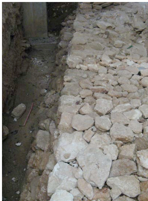
Fig. 146: Fotografía del refuerzo exterior en talud que se adosa contra el paramento externo de la muralla de la fase II de Tavira (Foto autor).
