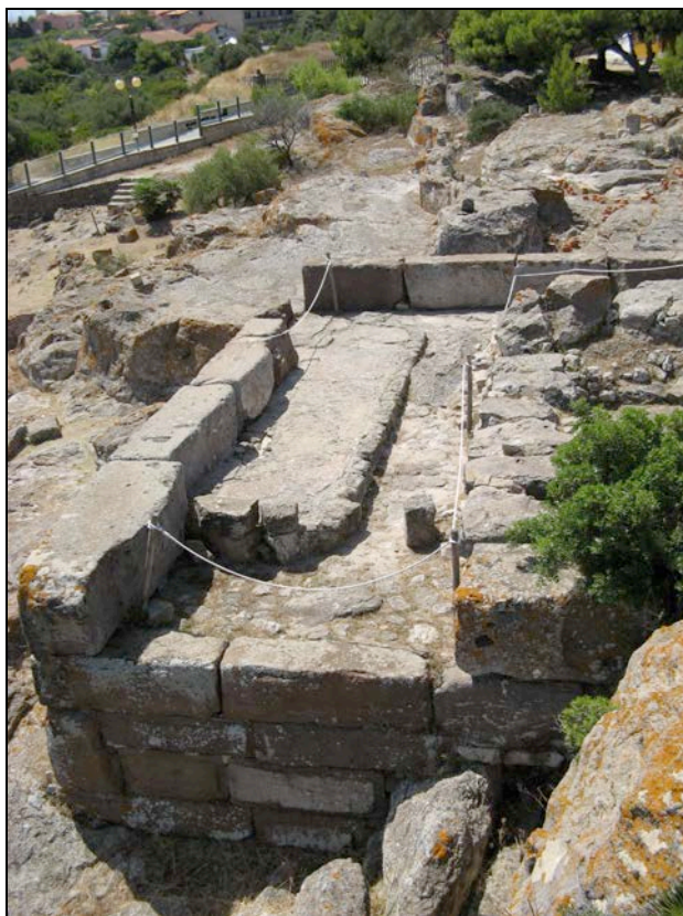
Fig. 167: Fotografía de la torre, aislada, erigida en el tofet de Sulky donde se puede apreciar el aparejo rectangular pseudoisódomo en traquita roja con ligero almohadillado y la cisterna “ a bagnarola ” asociada a la misma.
