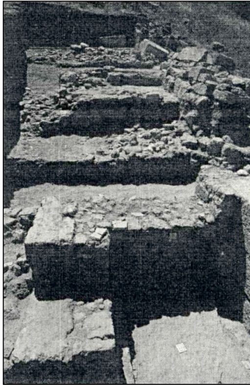
Fig. 205: Fotografía de la batería de artillería situada en la puerta VI de Agrigento donde se pueden observar los diversos compartimentos que conformaban su planta inferior y cuya construcción asociamos al período en que la ciudad fue ocupada por los cartagineses (Fiorentini, 2006).
