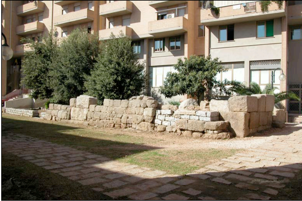
Fig. 71: Fotografía de la cara interna de la muralla de compartimentos de Olbia donde se puede observar la oclusión de una de las puertas de acceso a los mismos mediante pequeños mampuestos de granito, probablemente de época moderna (Foto autor).
