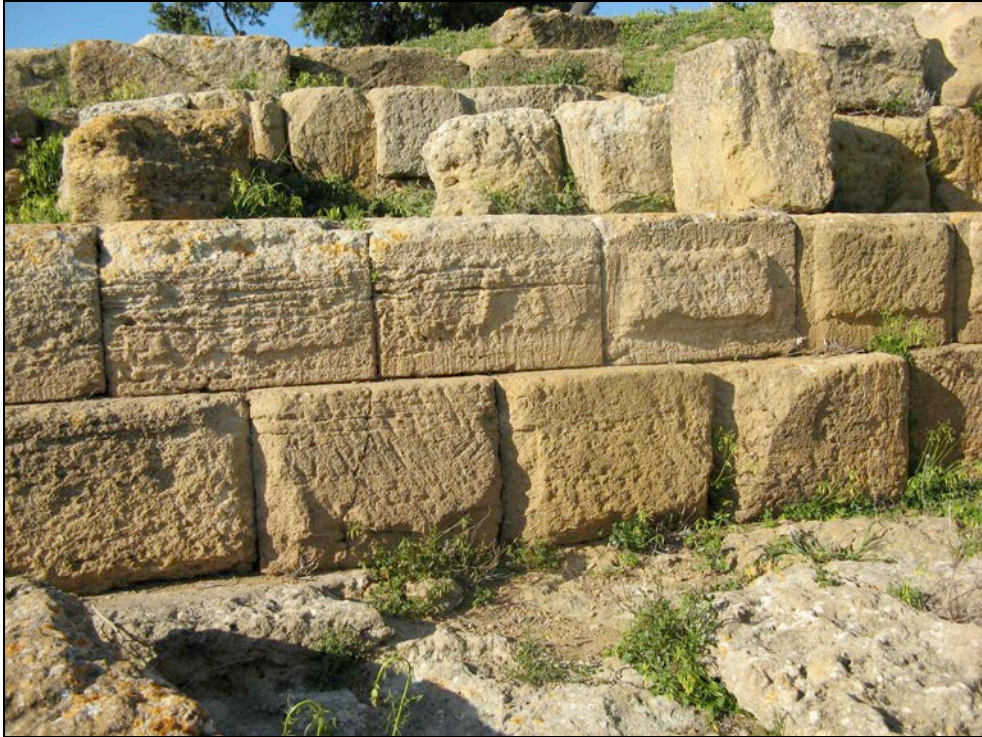
Fig. 55: Fotografía de la muralla arcaica de Agrigento erigida mediante aparejo rectagnular isódomo y donde se puede apreciar el almohadillado que presentan algunos sillares correspondientes, probablemente, a la reforma de inicios del siglo V a.C. (Foto autor).
