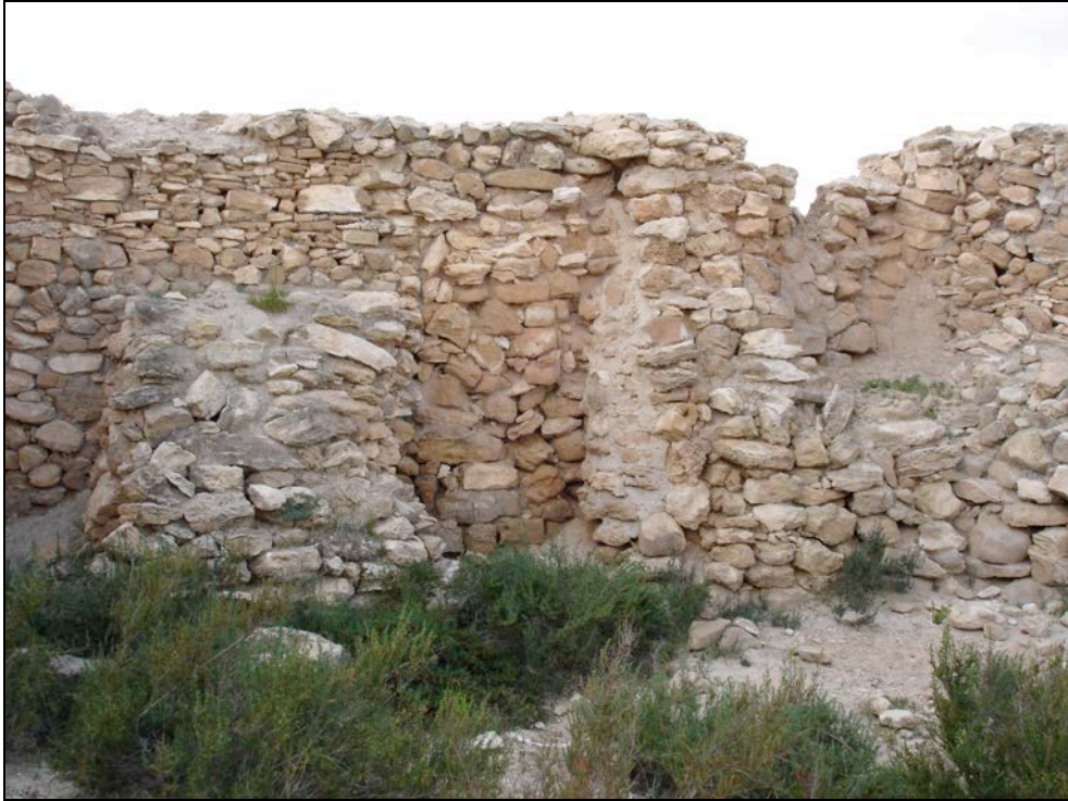
Fig. 145: Fotografía de los contrafuertes interiores en talud erigidos contra el paramento interno de la muralla de compartimentos en su sector sur durante la fase II (Foto S. Lacruz).
