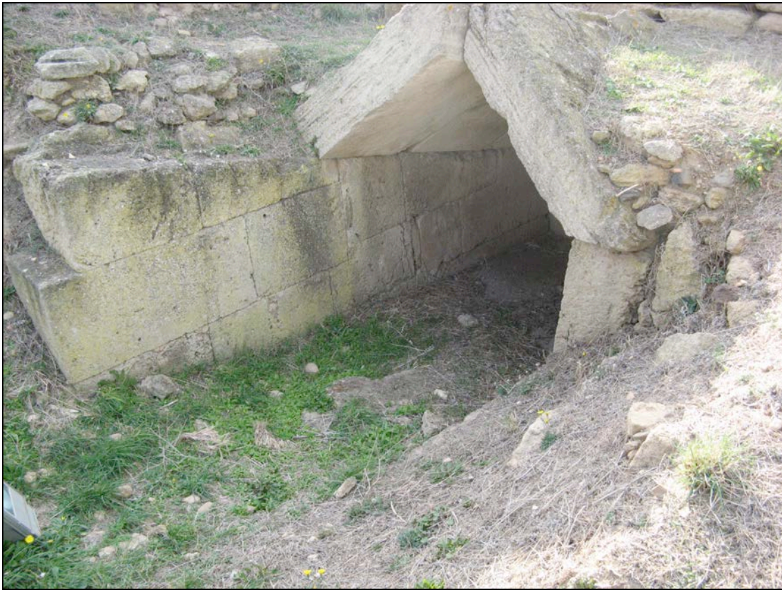
Fig. 271: Fotografía de la poterna 2 de Tharros , localizada en el sector de Muru Mannu y perteneciente a la fase I, donde se puede observa la cobertura a dos aguas de la misma y el acceso en rampa hacia el interior del asentamiento (Foto autor).
