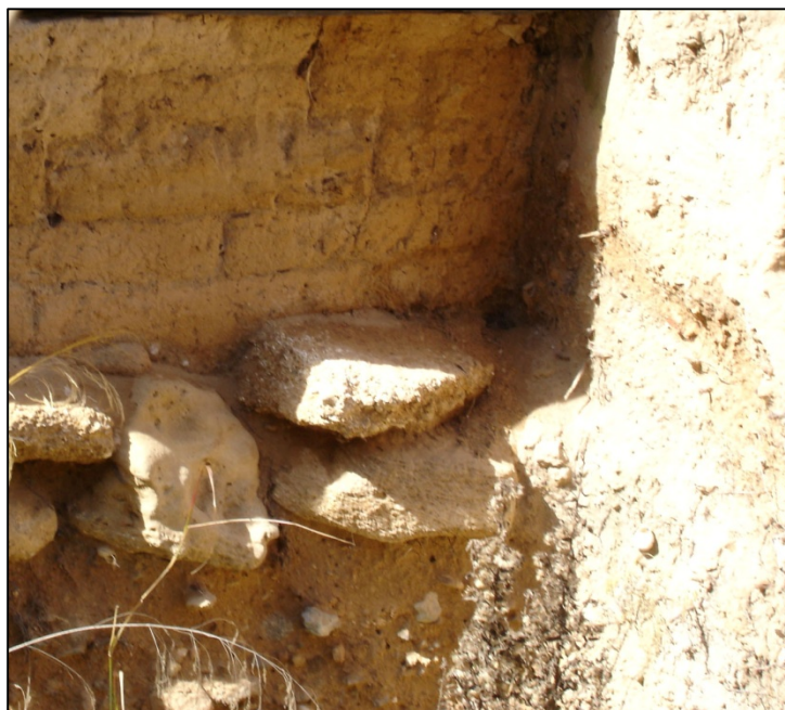
Fig. 130: Fotografía de los adobes que forman parte del muro exterior documentado en el sector meridional de La Fonteta (Foto S. Lacruz).
