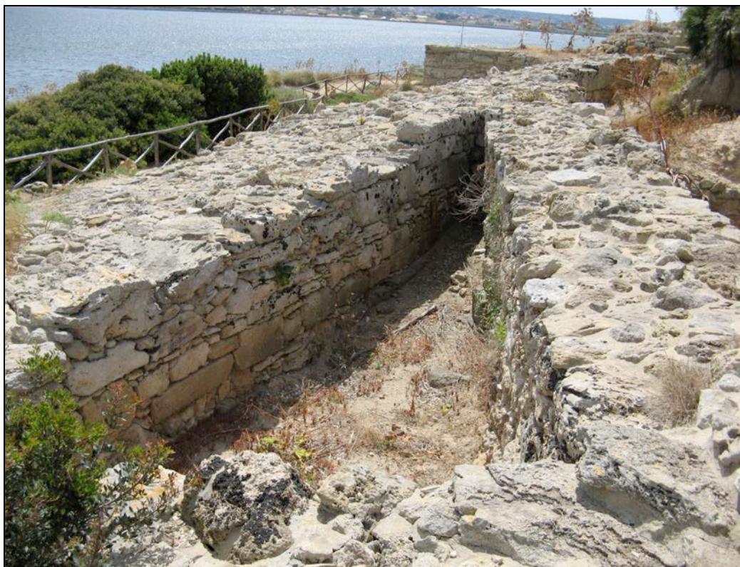
Fig. 149: Fotografía de la cara interna de la muralla de la fase IV de Mozia, a la izquierda, y la muralla de la fase I, a la derecha, ambas erigidas en mampostería (Foto autor).
