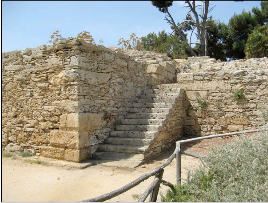
Fig. 231: Fotografía de la escalera adosada a la pared lateral de la torre NE de Mozia - tramo inferior- correspondiente a la fase IV de sus fortificaciones. Es posible que esta anomalía se deba relacionar con el uso del ariete por parte de las comunidades griegas establecidas en Sicilia (Foto autor).
