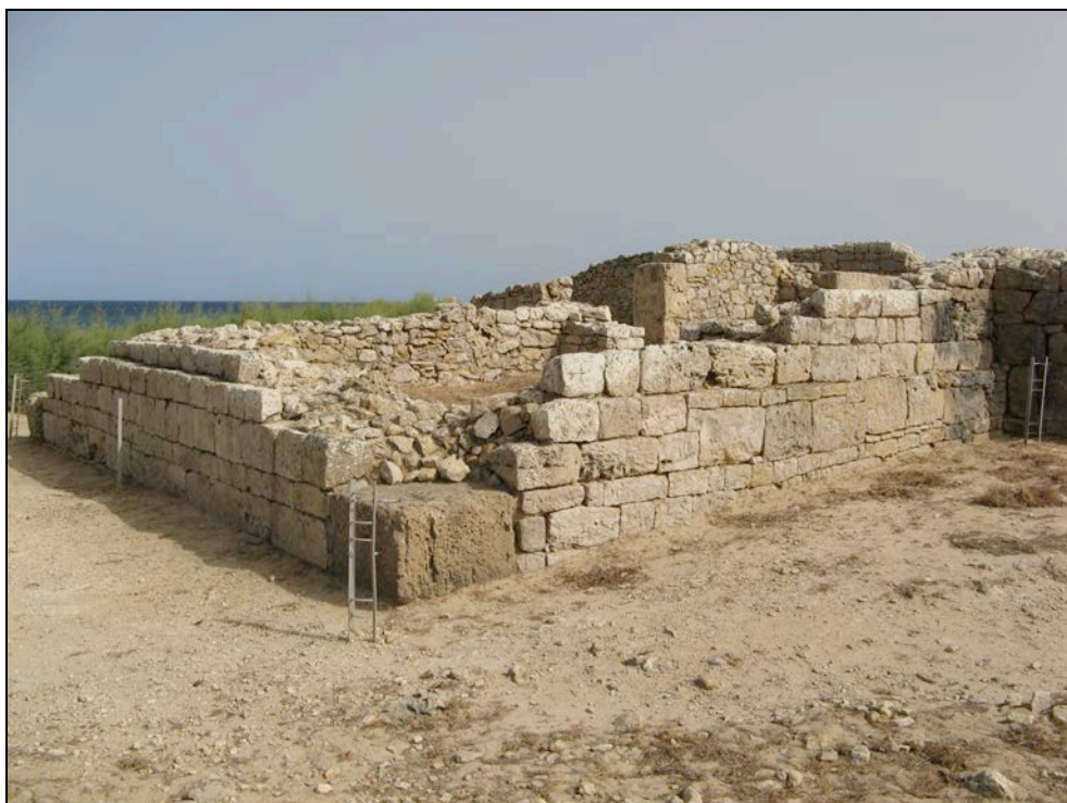
Fig. 170: Fotografía de la Torre A de la fase II de las defensas de Kerkouane donde se puede apreciar el aparejo rectangular pseudoisódomo empleado en su construcción, así como algún engatillado y pseudosillares (Foto autor).
