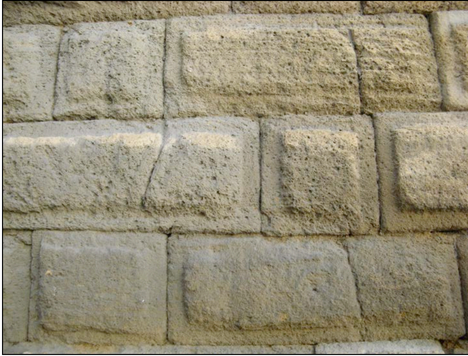
Fig. 95: Fotografía del aparejo rectangular isódomo con biselado y almohadillado presente en el Conjunto Monumental de la Puerta de Sevilla en Carmona (Foto autor).
