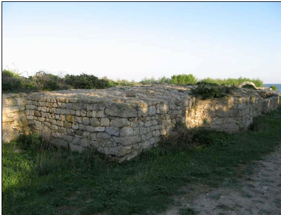
Fig. 238: Fotografía de la supuesta torre semicircular -E- identificada por M. H. Fantar y que nosotros consideramos como un refuerzo exterior de la torre D (Foto autor).
