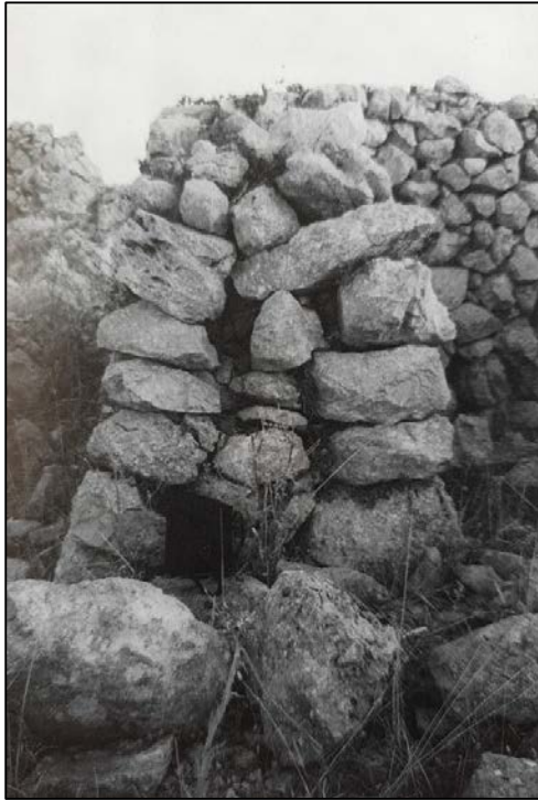
Fig. 69: Fotografía de uno de los muros de sección trapezoidal erigidos en piedra seca documentado en Cozzo San Rocco, en los Monte Billiemi cercanos a Palermo (Mercadante, 2006).
