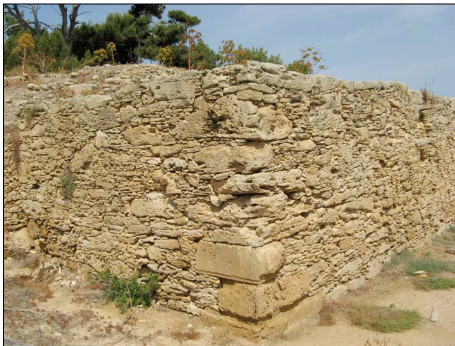
Fig. 157: Fotografía de los grandes bloques de piedra, algunos de ellos reutilizados, presentes en las esquinas de las torres de la fase IV de las fortificaciones de Mozia (Foto autor).
