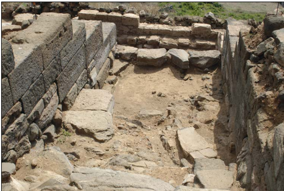
Fig. 166: Fotografía del aparejo rectangular pseudoisódomo empleado en la puerta de acceso a la acrópolis de Kossyra donde se pueden observa los sillares con su cara totalmente lisa y cuyas hiladas presentan diferentes alturas (Cassarà, 2015).
