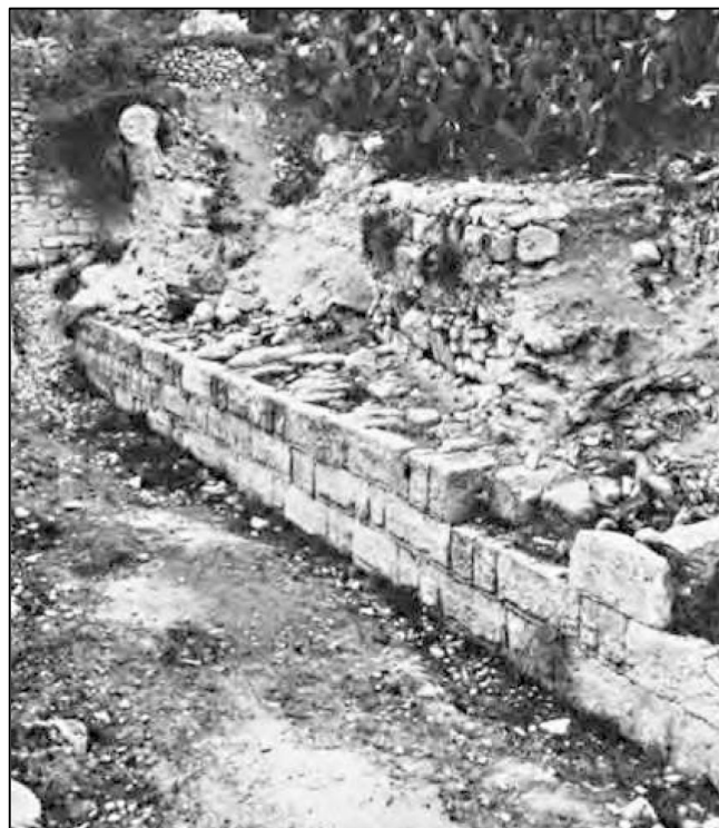
Fig. 32: Paramento exterior de la muralla correspondiente a la fase “Building Period II” erigida mediante sillares colocados a soga y tizón (Aubet Semmler, 2014).
