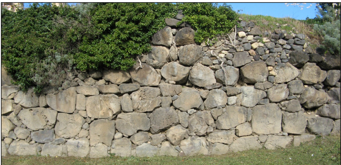
Fig. 84: Fotografía del muro de contención de época romano identificado en el sitio de Su Palattu en Padria (Foto autor).
