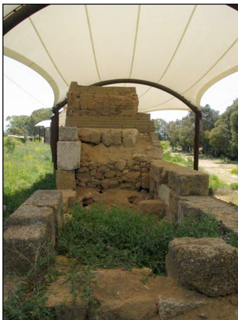
Fig. 54: Fotografía de la muralla de cajones de la fase I en Gela con el alzado de adobes perteneciente a la fase II (Foto G. De Prado Cordero).
