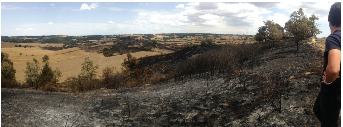
Fig.2_8 Incendio de Rocallaura, 2017
