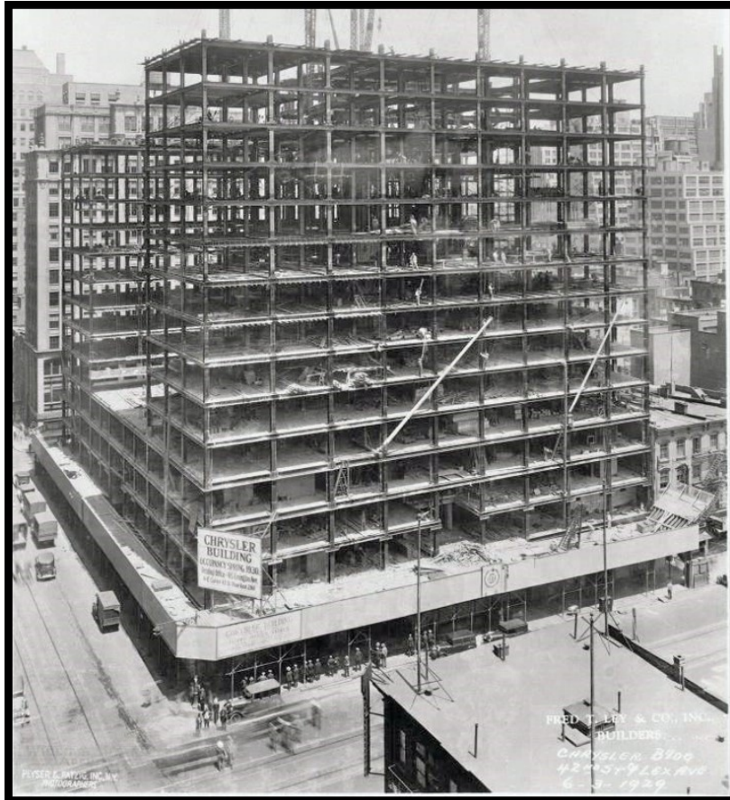
Fig. 72: El edificio Chrysler en construcción. Fotografía fechada el 3 de junio de 1929.
