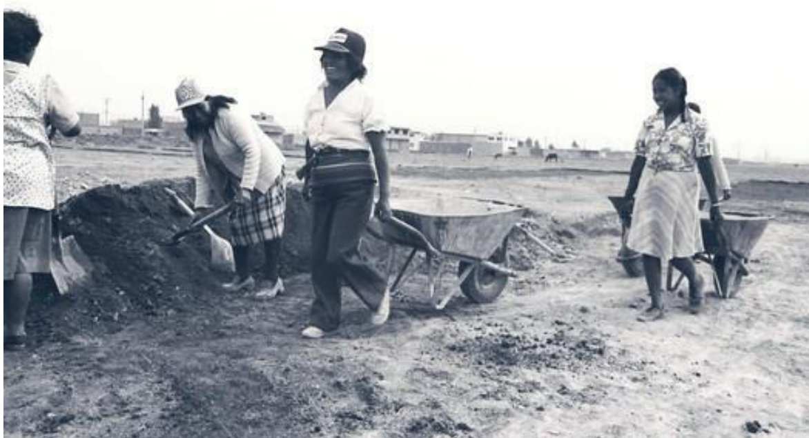
Imagen 29. Las mujeres en la construcción. Participación de las mujeres en la construcción de las viviendas. Fotografía: Archivo Alejandro Suárez Pareyón.
