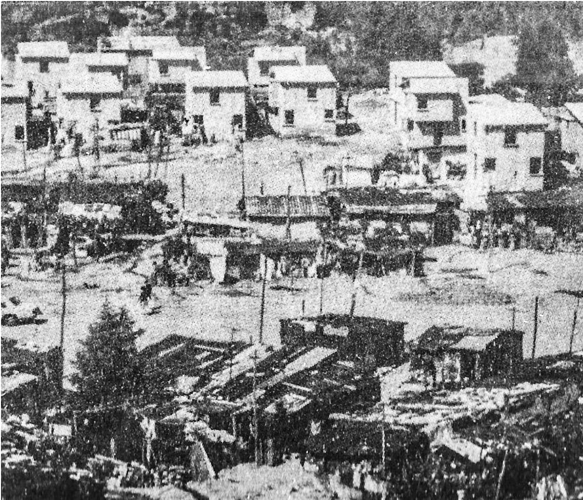
Imagen 12. Transformación del asentamiento. Viviendas nuevas y viviendas precarias en el asentamiento de Palo Alto durante el proceso de construcción. Fotografía: COPEVI, 1987.
