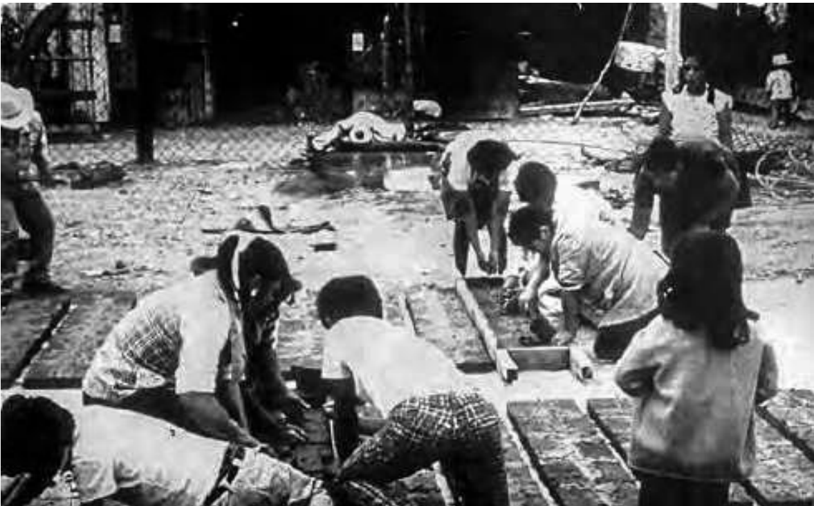
Imagen 9. Las mujeres y los niños en la autoconstrucción. Participación de mujeres y niños en la fabricación de cerámica armada para los techos de las viviendas. “Fue una etapa muy bonita del proceso y de mucha convivencia entre los miembros de la cooperativa” (Entrevista PAMF02, 23/04/2017). Fotografía: Ortiz, 2016.
