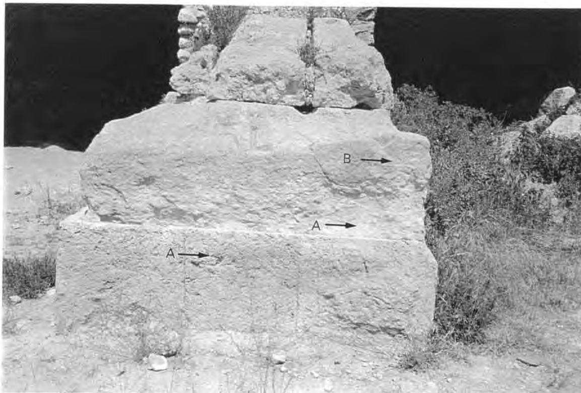
An-8/22.F-1 Superficie alveolizada, criptoflorescencias (A) y costra gris (B)
