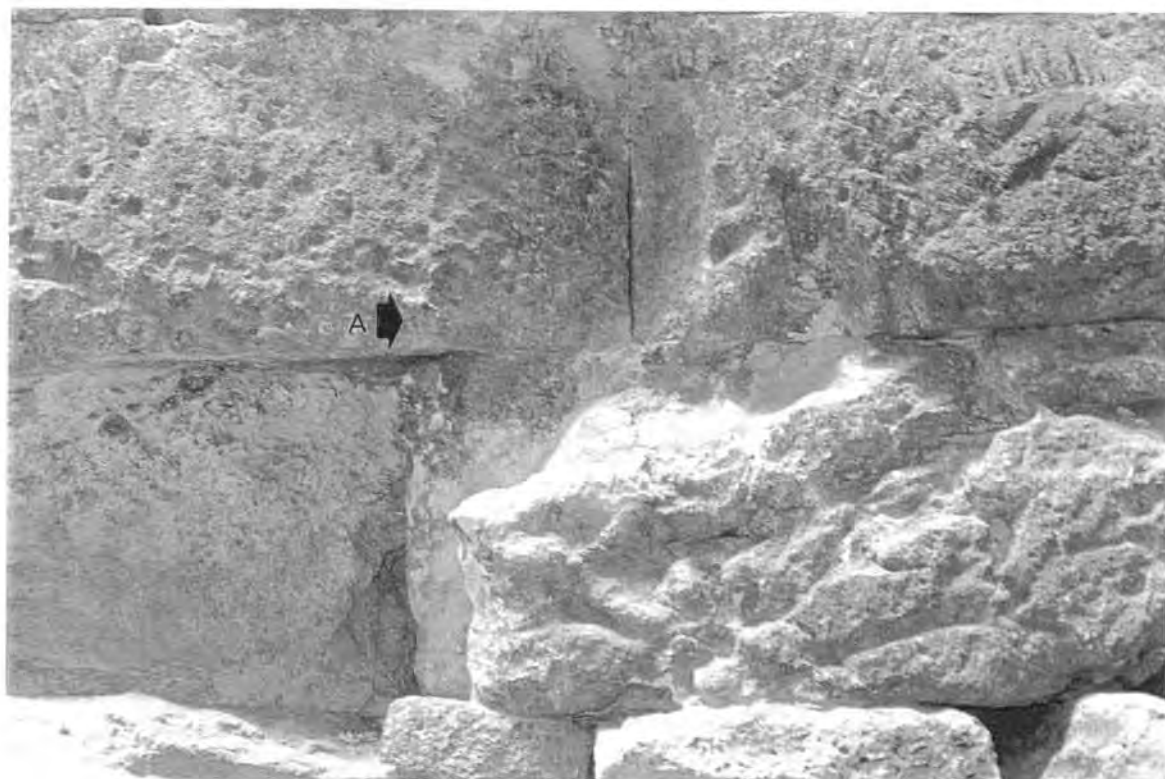
An-8/13.F-1 Costra gris oscura, en la "Baixada del Roser" Tipo A: BRY 1
