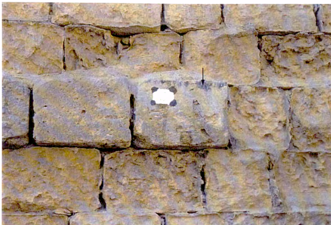
An-8/8.F-1 Costra gris con áreas ennegrecidas An-8/8.F-2 Detalle de la foto anterior
