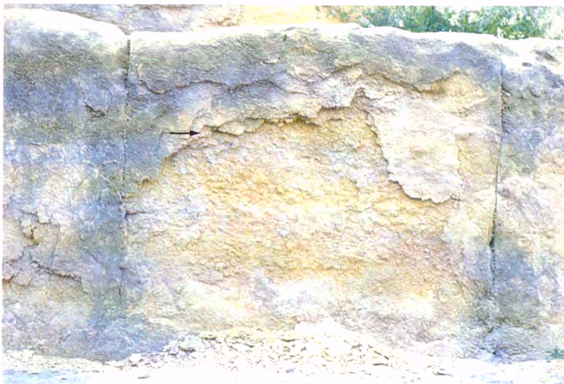
An-8/34.F-1 Anfiteatro, Sector C. Nódulos salinos sobre un contrafuerte
