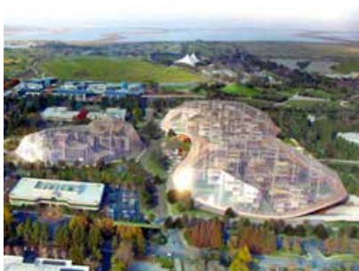
FIG. 19 BIG y Heatherwick Studio, Google Campus , California, EE. UU. No es casual que en la actualidad el nuevo Campus de Google diseñado por los arquitectos Bjarke Ingels y Heatherwick sea una membrana orgánica de vidrio, una "burbuja cobertora en forma de saco amniótico" que diluye los espacios de trabajo. Según sus arquitectos "En vez de construir edificios de hormigón inamovibles, creamos estructuras ligeras que se podrán mover fácilmente. Grandes toldos translúcidos cubrirán el emplazamiento, controlando el clima dentro, dejando pasar luz y aire(...) Tenemos el objetivo de diluir la distinción entre nuestros edificios y la naturaleza." De la misma manera que sucedió en Drop City, Google desdibuja su campus con un anti-diseño donde lo que realmente es importante son las propias pulsiones vitales del hombre y la creatividad de sus trabajadores para diseñar la supervivencia de la sociedad en combinación con las nuevas tecnologías.
