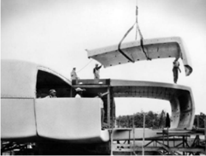
FIG. 13 Monsanto, Casa del Futuro , Estructura de plástico, construcción, Disneyland, EE. UU., 1957 ©Supplied.
