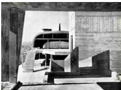
FIG. 19 Le Corbusier, Unité d'habitation, Marseille, Francia, 1952.
