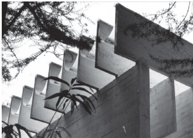
Detalles de la cubierta y los árboles. Pabellón Nórdico en la exposición mundial de Bruselas, 1962. Sverre Fehn. Fuente: SÁNCHEZ. Op. Cit. Pág. 98
