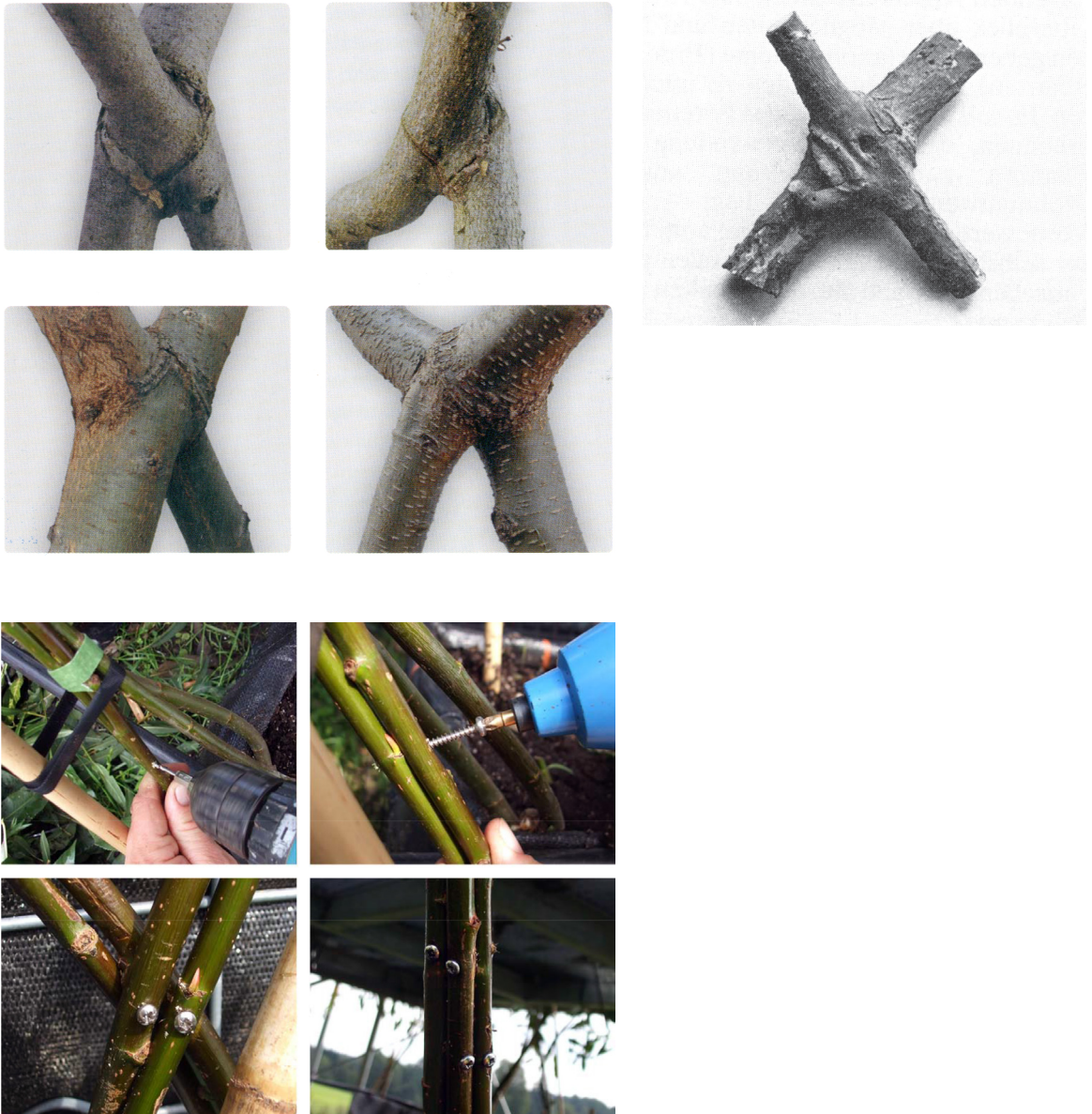
Arriba: Tipos de nudos. Abajo: conexión de las plantas a la torre. Arriba: pre-taladrado y atornillado con tornillo de acero inoxidable. Inferior: Premontaje en cruz y conexión en paralelo (punto de suma). Fuente: LUDWING, Ferdinand; SCHWERTFEGER, Hannes y STORZ, Oliver. "Living Systems. Designing Growth in Baubotanik." Architectural Design March/April 2012: 82-87 y LUDWING, Ferdinand. "Botanische Grundlagen Der Baubotanik Und Deren Anwendung Im Entwurf Botanical Basics of Baubotanik and Their Application in Design". Op. Cit. Pág. 226
